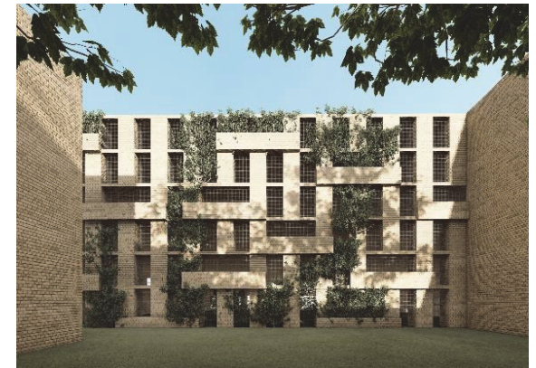
Pysäköintitalojen julkisivut tehdään tuulta läpäiseviksi katujen tuuliolosuhteiden parantamiseksi.
