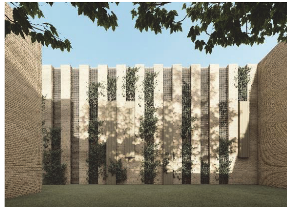
Pysäköintitalojen julkisivut tehdään tuulta läpäiseviksi katujen tuuliolosuhteiden parantamiseksi.
