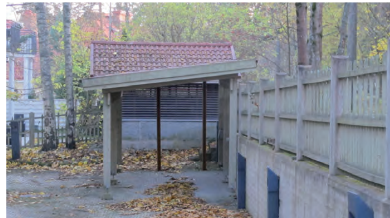
Vuonna 2001 rakennettu autokatos.
