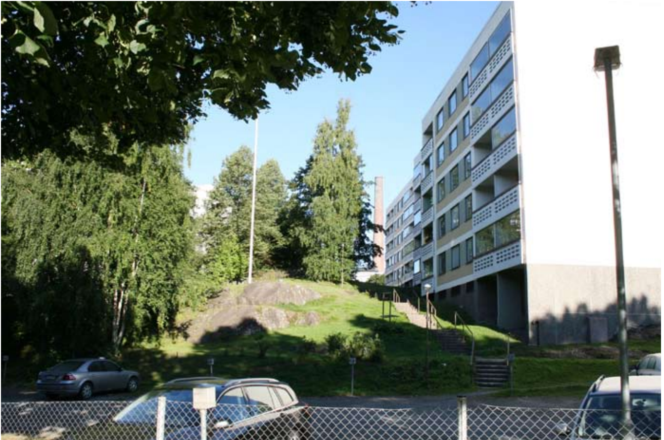
Vuoden 1972 asuinkerrostalo osoitteessa Lapintie 9, yllä lounaisjulkisivu, alla koillisjulkisivu. Julkisivut ovat maalattua betonia, sokkelit ja kaakkoispäädyssä alin kerros pesubetonia.
