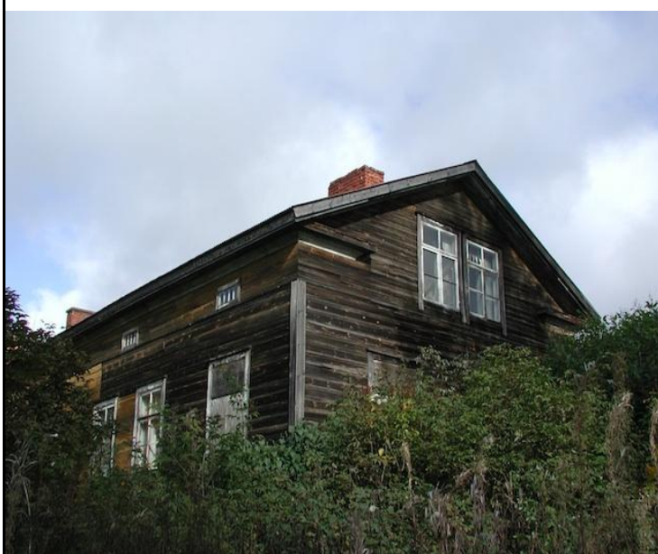
1.2.Pirtin kaakkoispääty, joka on rakennettu uudestaan v.1939 jälkeen, sen vaurioituttua pommituksissa.
