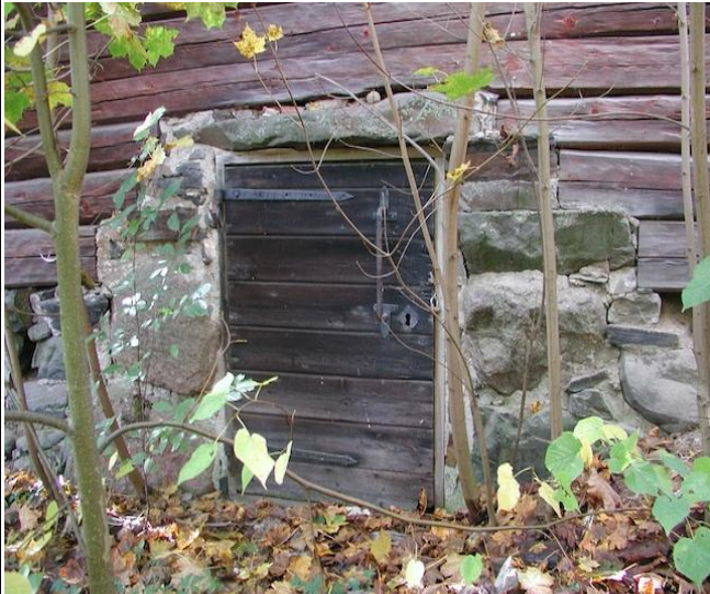
1.4.Kellarin koillispäädyn sisäänkäynti.
