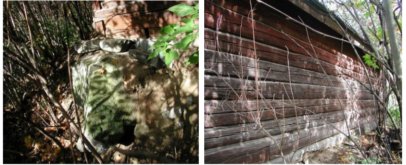
1.4.Kellari, kaakkoissivun nurkkakivi ja hirsiseinää.
