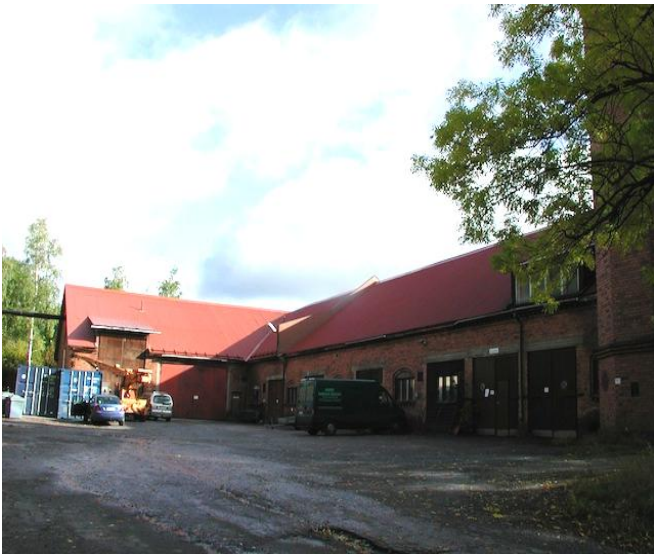
1.3.Navetan luoteissivuun tehdyt muutokset.
