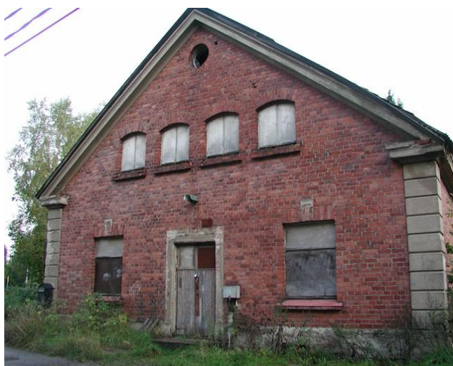
1.Saunan kaakkoissivu ja lounaispääty, joissa ikkunoiden ja ovien koristerappaukset rapautuneet.
