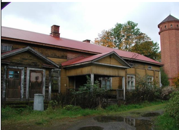
12. Pirtin kaakkoissivun pohjoispää
