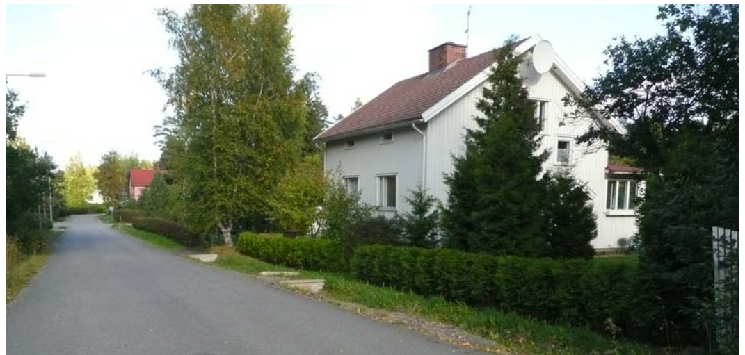
Puomikadun varrella sijaitseva asuinrakennus on tarkoitettu säilyttää.
