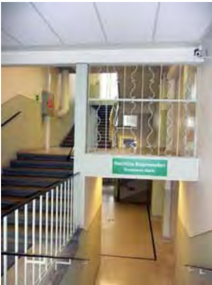
Pohjoissiiven vanhimman osan monimutkainen porrashuone on monen muutoksen summa
