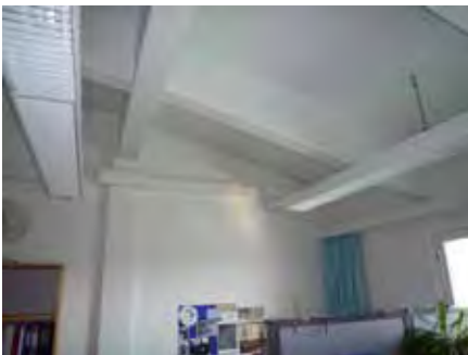
Ullakkokerroksen toimistotilan kaareva betonikatto
