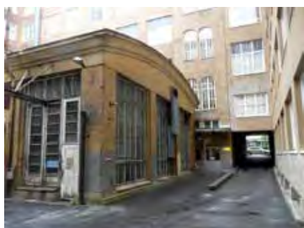
Pannuhuone ja porttikäytävä. Pannuhuoneen ikkunat ja ovi ovat puisia.
