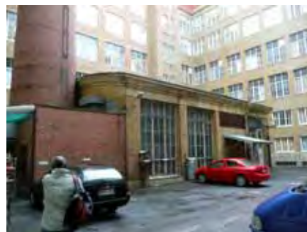
Ylempi kuva: pannuhuoneen itäsiivu ja porttikäytävä Satamakadulle
