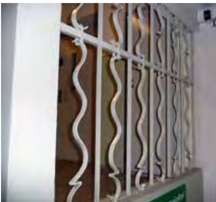
Pohjoissiiven porrashuoneen koristeellinen suojakaide 1930-luvulta
