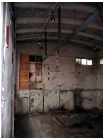
Pannuhuone sisältä nykyasussaan, lämpökattilat on poistettu
