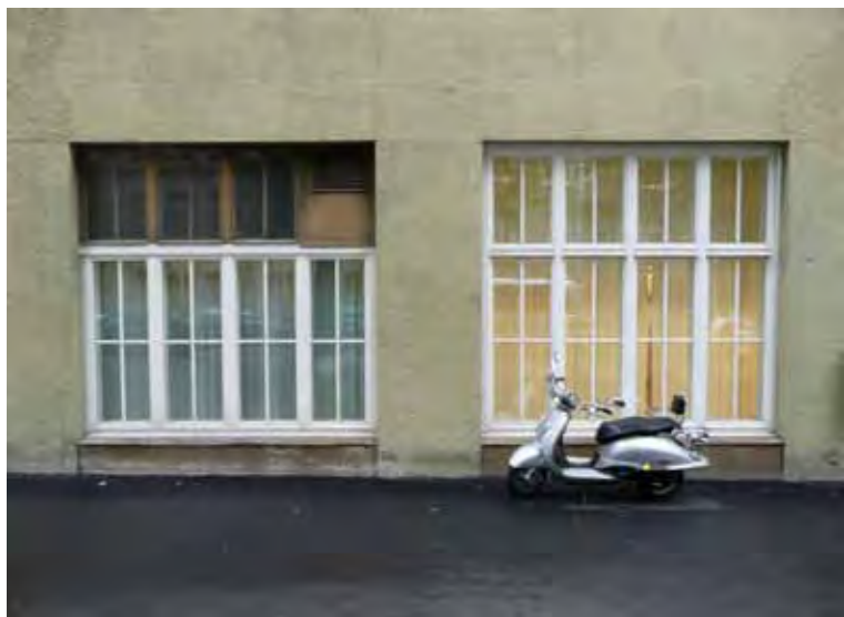
Koulukadun julkisivun ikkunoita – alakattojen yläpuolelle jääneiden ikkunoiden yläosiin on Koulukadun ja Satamakadun julkisivuilla sijoitettu ilmanvaihtoaukkoja
