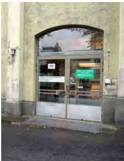
1960-luvun sisäänkäynti Satamakadun julkisivun länsipäädyssä
