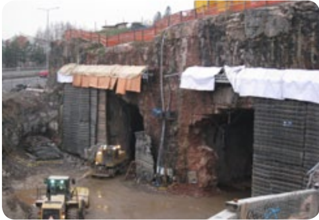
Kuva 47. Kehä I:n Vallikallion tunnelin työmaata, tulevan kalliotunnelin suuaukko.
