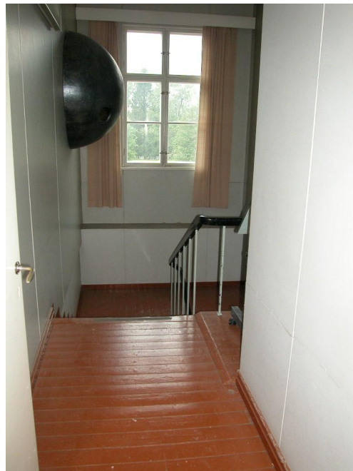
Portaikko kellarikerrokseen eteläpäädyssä. Portaissa on vielä puupinta, muuten lattiat on uudelleenpäällystetty muovimatolla tai laatoin.
