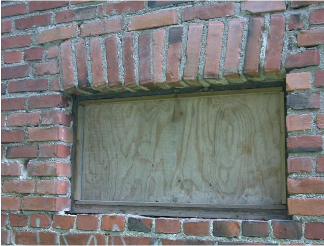
Rakennuksen luoteiskulmassa sijaitsee alakerroksen ainoa ikkuna-aukko.
