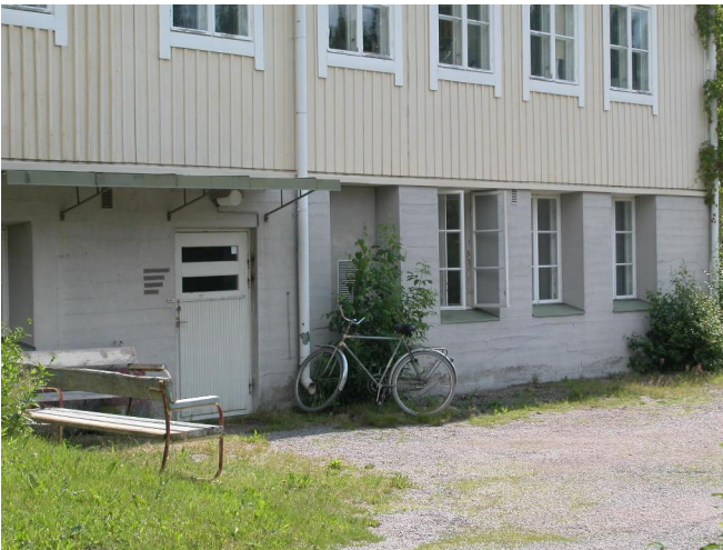
Rakennuksen eteläpäädyssä perustus vaihtuu lohkokivestä betonisokkeliksi
