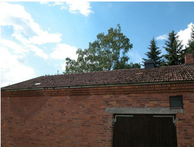
Makasiinin tiilikattoa korostaa klassinen, porrastettu räystääsmuuraus.
