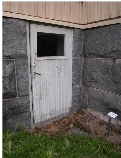
Rakennuksen eteläpäädyssä perustus vaihtuu lohkokivestä betonisokkeliksi
