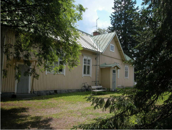
Asuinrakennus pihapiirin puolelta luoteesta.
