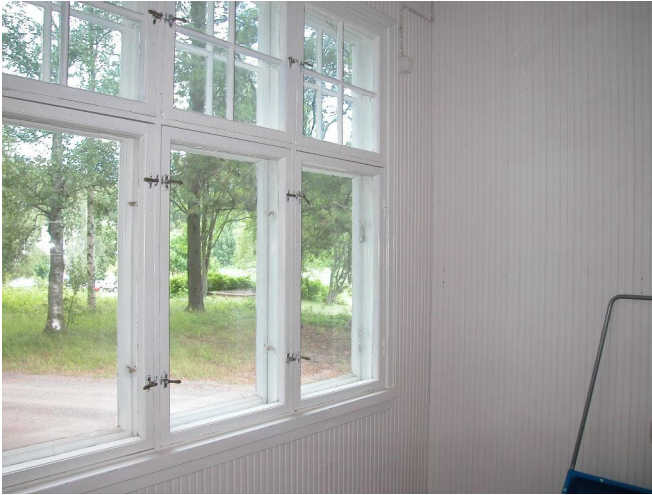
Pohjoispäädyn asunnon keittiö. Ikkunat ja seinäpaneli ovat alkuperäisiä.
