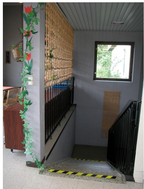
Sisäportaikko toisesta kerroksesta alas.
