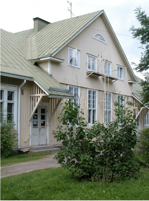
Itäjulkisivu kaakosta. Eri ikkunamallit, ovet, katokset ja poikki pääty rytmittävät julkisivua monipuolisesti mutta sopusuhteisesti.
