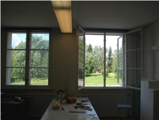
Työhuone eteläpäädyn kellarikerroksessa. Huoneiden ikkunat ovat säilyneet hyväkuntoisina ulkoa ja sisältä.
