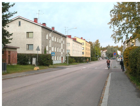
Kissanmaankatu kohti luodetta. Alkuperäisen kaavasuunnitelman mukaan rakennusten eteen oli tarkoitus istuttaa puistokaduille tyypillinen puurivi.
