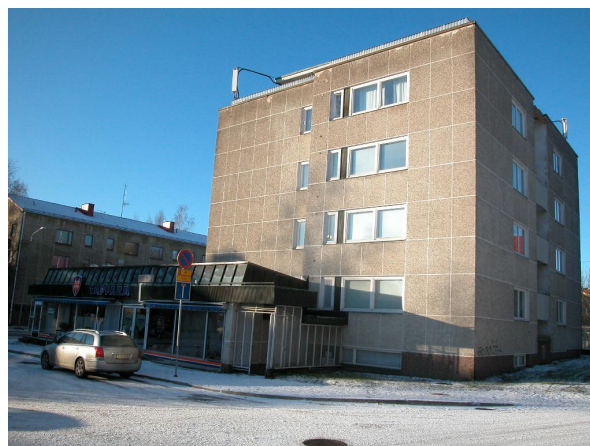
1960-luvun alun tiilirunkoinen nelikerroksinen kerrostalo Kissanmaan aukion reunassa (Kissanmaankatu 9).
