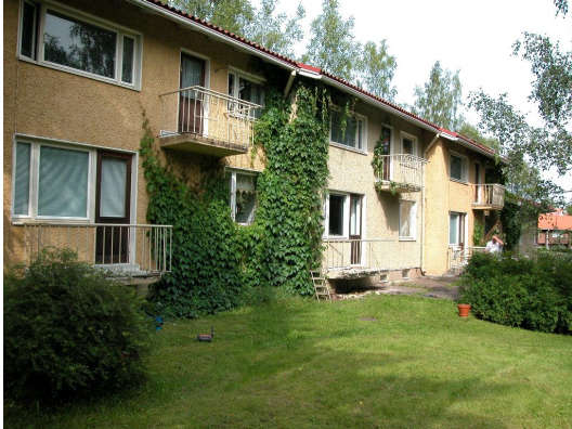
1950-luvun puolivälin rapattupintainen 7-asunnon rivitalo (Majavankatu 4).
