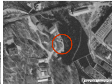
vuoden 1966 ilmakeu Kuvassa näkyy 1960 rakennettu pukukoppi ja kirkkovenekatos
