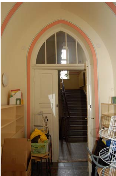
Näkymä Koulukadun vanhasta portaikosta porrashuoneeseen. Huoneen nykyinen lattiataso portaiden ylimmällä tasanteella.
