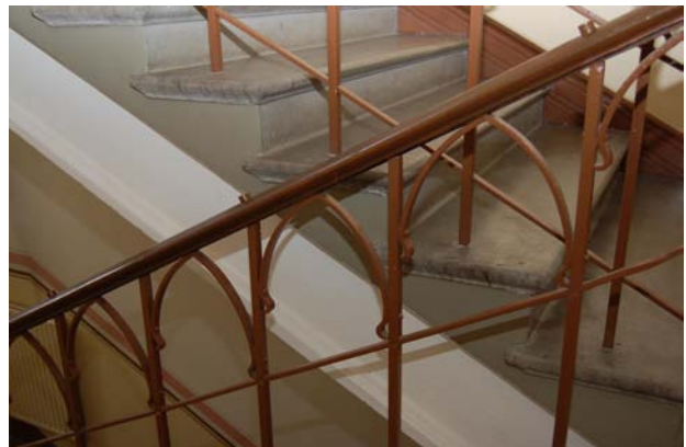
Porrashuoneen alkuperäiset rautaiset kai- teet ja kaidepuut.
