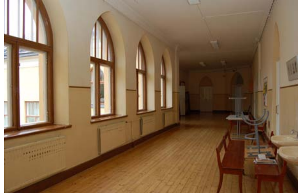
Koulukadun puoleinen käytävä etelästä päin. Vasemmalla ikkunat sisäpihalle päin.
