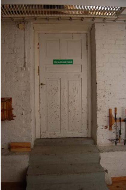
Ulko-ovi sisäpihalle, länsi-seinä. Ovi teknisentyön tiloissa.
