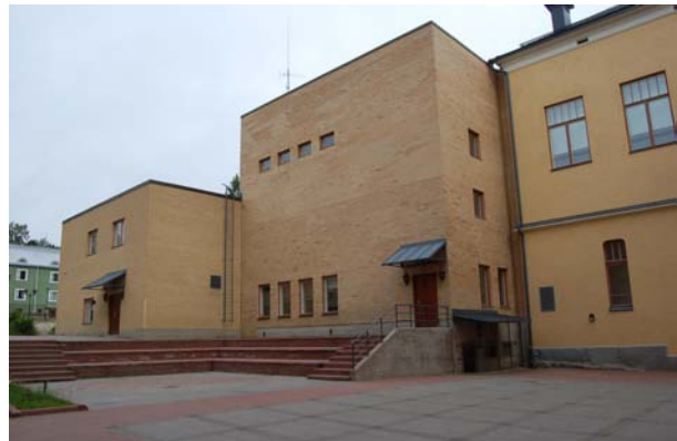
Näkymä koulun sisäpihalta, etelä. Kaksi tiilistä lisärakennusta.
