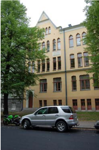
Osa Koulukadun puoleista julkisivua. Erityispiirteinä koristepääty sekä ikkuna- aukotuksen symmetria.
