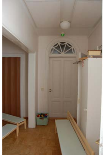
Salista aukeava näkymä pohjoiseen. Eri-tyyppipiirteinä kamanan lunetti-ikkuna, jotka toistuvat myös muualla rakennuksessa.
