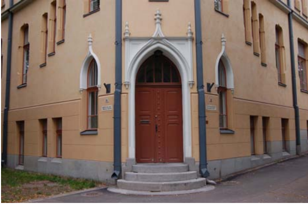
Portaali Koulukadun ja Satamakadun kulmassa.
