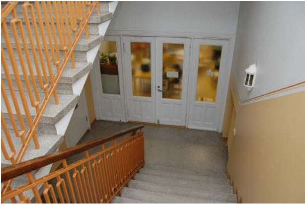
Kuva 2. ja 3. kerroksen välitasanteelta 2. kerroksen vanhan salin oviin.
