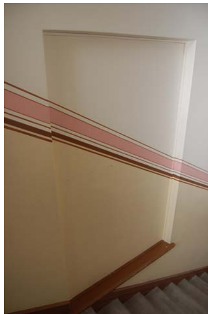
Vanha aukko 1. ja 2. kerroksen välissä pohjois-seinällä. Koristemaalaukset ovat rekonstruktio alkuperäisistä.
