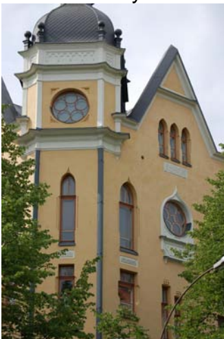
Kulmatorni ja koristepääty kuvattuna pohjoisesta, Satamakatu.
