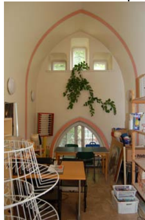
Koulukadun puoleisen sisäänkäynnin entinen porrashuone, nykyisin erillinen huone. Lattiataso vanhan portaikon yläpäässä.
