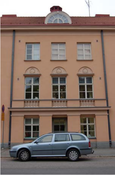
Osa julkisivua Mariankadun puolelta, länsi. Vanha pääsisäänkäynti.
