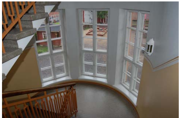
1. ja 2. välisen kerroksen ikkunat kuvattuna 2. kerroksesta. Ikkunat itään.
