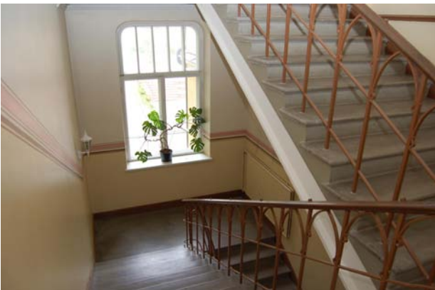
Näkymä 3. kerroksesta alas välitasanteelle.
