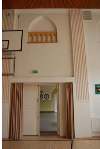
Voimistelusalin koristellut pilasterit. Ylhäällä vanha kaariaukko, levytetty umpeen, jonka kaide on alkuperäinen. Vasemmalla, kuvan ulkopuolella on toinen samanlainen kaiteellinen kaari.
