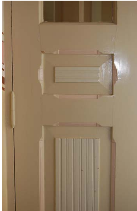
Porraskäytävään Koulukadun puoleiselta käytävältä johtava ovi, 3. kerros.
