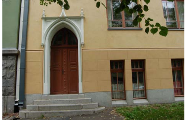
Koulukadun puoleinen portaali.
