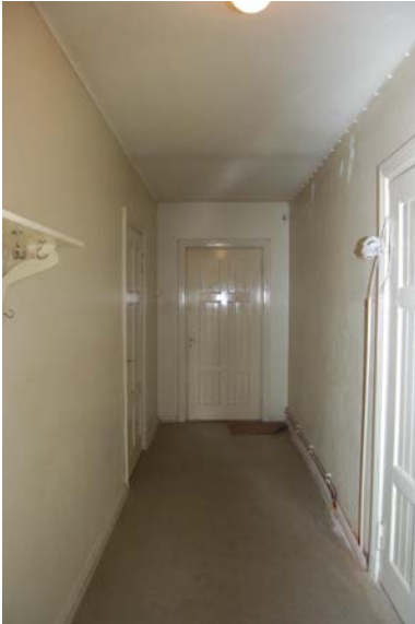
3. kerroksen käytävä pohjoiseen. Kerroksessa yksityisasuntoja.
