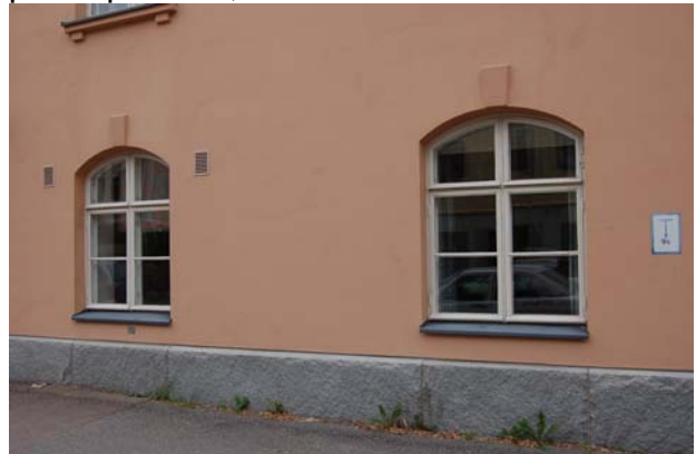
Mariankadun puoleiset 1. kerroksen ikkunat.
