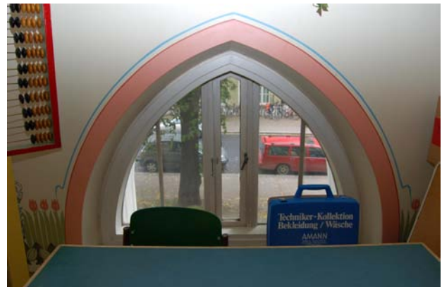
Lattian rajaan jäävä ikkuna. Ikkuna on osa lattian alapuolella jatkuvaa ulko-ovea.
