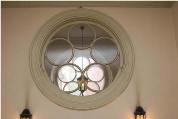
Pihanpuoleisen sisäänkäynnin pyöreä ikkuna. Samanlaisia ikkunoita myös muualla rakennuksissa. Satamakadun puoleinen siipi.
