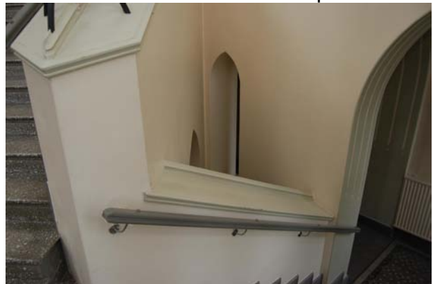
Näkymä 2. ja 3. kerroksen välitasanteelta alas. Kuva Satamakadun suunnasta.
