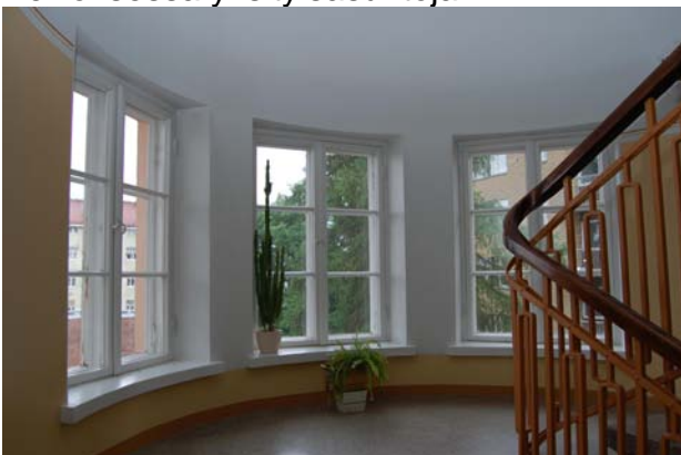
3. ja 4. kerroksen (vintin) väliset ikkunat. Ikkunat itään.
