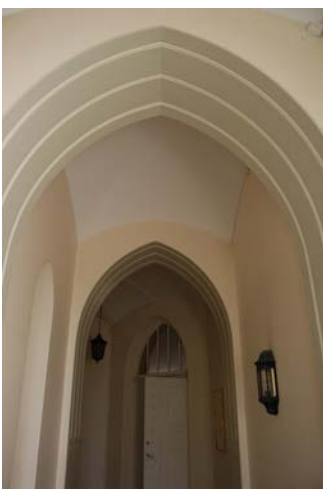
2. kerrokseen johtava ovi. Kuva Satamakadun puolelta.
