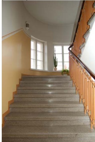
Kuva 3. kerroksesta ylös 3. ja 4. kerroksen (vintin) välitasanteelle.
