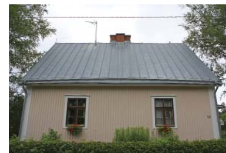
Uusittu peltikate odottaa maalausta.
