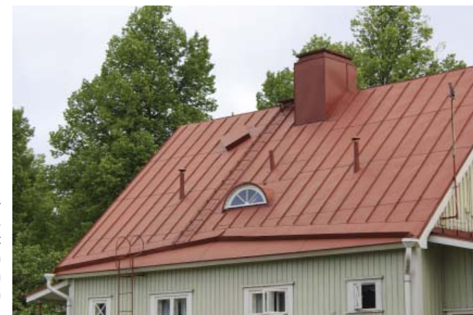
Uusittu peltikate odottaa maalausta.
