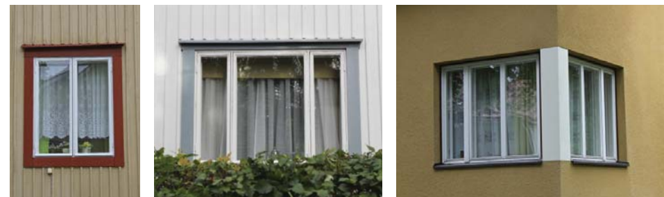
Perä-Petsamon puitejaoltaan yksinkertaisia ikkunatyyppejä
