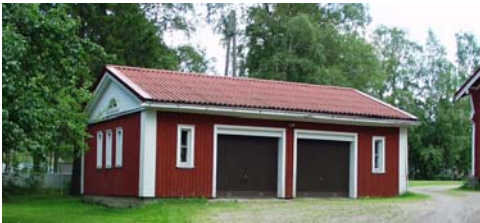
Uusi autotalli aittarakennuksen vasemmalla puolella.
