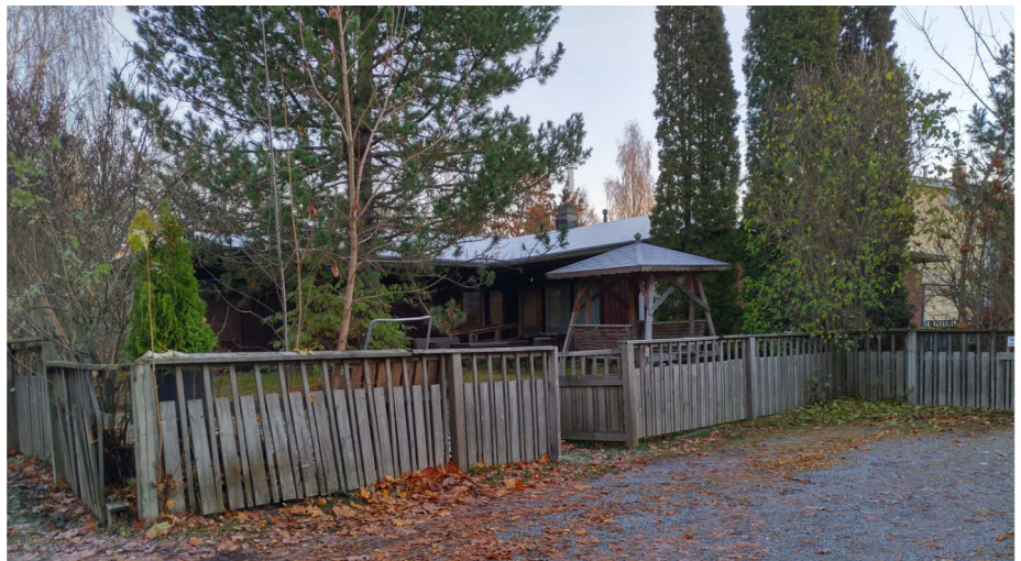
Kuvassa Pispalan valtatie varren tontti, jolla sijaitsee 1970-luvulla rakennettu tiili- ja puuverhoiltu, yksikerroksinen omakotitalo.
