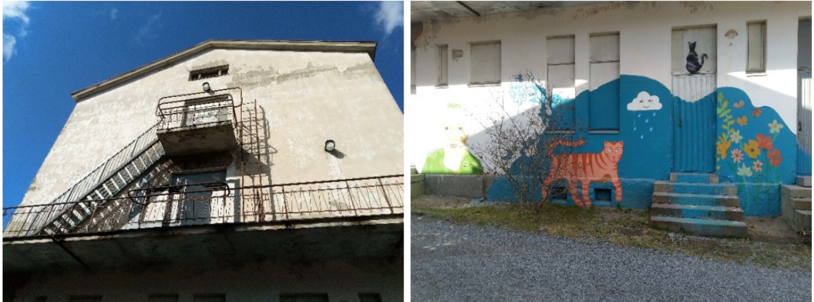
Kuva 9. Kulkusairaala on tiilirakenteinen. Ulkoisesti tarkasteltuna ei havaittu sopivia aukkoja tai rakoja perustuksissa tai yläkatossa. Ullakkotilaan on kuitenkin päässyt lintuja, joten myös lepakoilla on mahdollista päästä ullakkotilaan.
