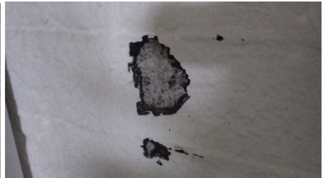
Kuvat 17 a ja b. Tilassa 006 kantavan väliseinän maalipinta on paikoin lohkeillut ja irronnut alustastaan. Maalipinnan alla on pikisively.
