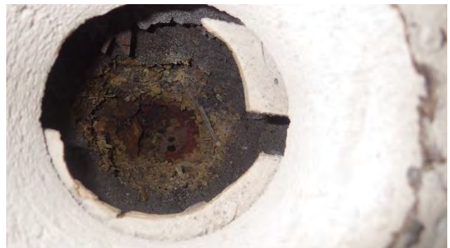
Kuvat 42 a ja b. Rakenneavaus RA-YP2 lastentalon palopermantoon. Yläpohjan eristeenä on käytetty kevytbetonia, koksikuonaa ja kutterilastua. Mukana myös tiilenkappaleita.
