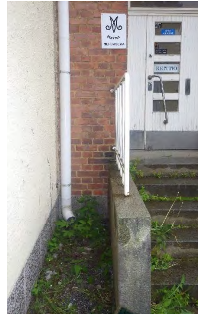
Kuvat 6 a-c. a) Lastentalon pohjoisseinustan sisääntulon kohdalla katolta tulevat sadevedet ohjataan portaikon vierustoille. b) Kellarikerrokseen johtavan luiskan seinämässä on runsaasti kosteuden aiheuttamaa kalkkihärmää. Luiskan alatasanteen sadevesikaivon vedenpoistossa ongelmia. c) Keittiön sisäänkäynnin vieressä katolta tulevat sadevedet lasketaan suoraan maahan.
