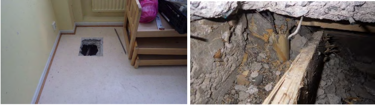
Kuvat 29 a ja b. a) Rakenneavaus RA-VP1 tilassa 105. b) Muottilaudat osin paikoillaan. Eristeenä on käytetty koksikuonaa.
