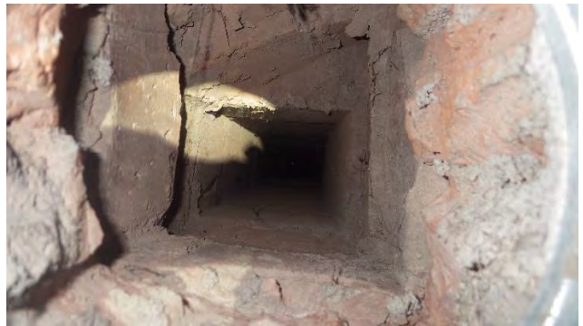
Kuvat 37 a ja b. a) Rakennusaineisia ilmanvaihtokanavia ullakkotilassa. Tarkastusluukusta tarkasteluna kanavissa oli voimakasta ilmavirtausta. b) Pystyhormi tarkastusluukusta tarkasteluna.
