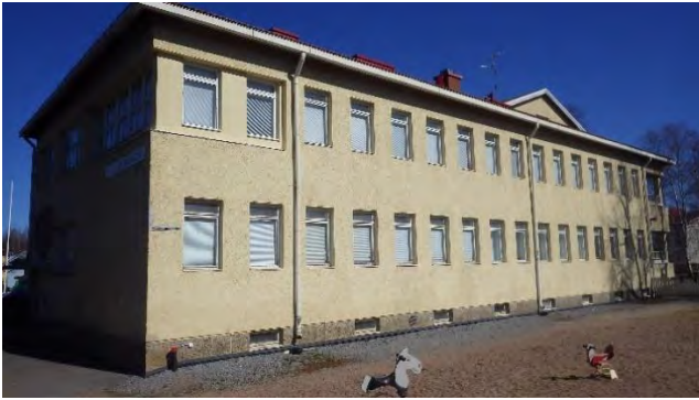
Kuvat 5a ja b. a) Lastentalon etelän puoleiselle sivustalle on asennettu jälkikäteen perusmuurilevy sekä sadevesiviemärointi lastentalon kellarikerroksessa havaittujen kosteusongelmien johdosta. Kellarikerroksen ikkunat ovat hyvin lähellä maanpintaa. b) Lähikuva perusmuurilevystä.
