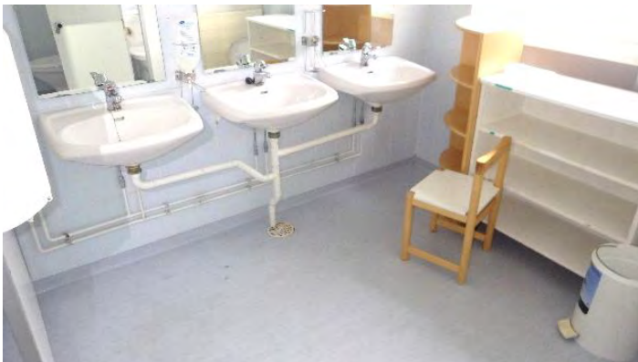
Kuva 57. Yleiskuva päiväkodin käytössä olleesta wc-tilasta (tila 217). Ei poikkeavia pintakosteusilmaisimen lukemia lattiassa tai seinissä.
