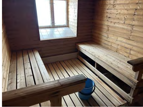
Kuvat 47 a ja b. Kuvat asuntosiiven kellarikerroksen saunasta (tila 030). Suositellaan lauteiden uusimista, jos mahdollisia laajempia korjauksia ei tehdä lähiaikana.
