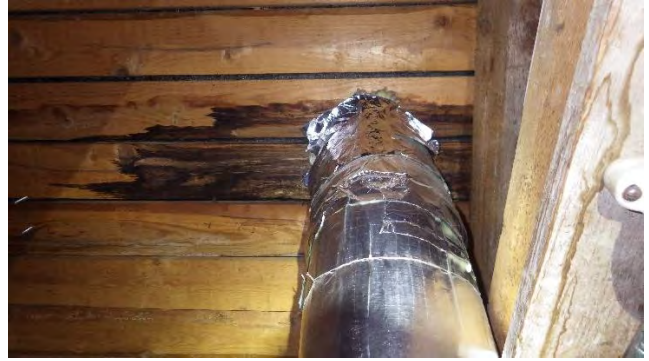
Kuvat 36 a ja b. a) Yleiskuva asuntosiiven ullakosta. Ullakon keskiosalla on vanhoja hormeja sekä rakenneaineisia ilmanvaihtokanavia. Ullakkotiloissa on erillisiä varastokoppeja. b) Yksittäisissä kattoläpivienneissä havaittiin vanhoja vuotojälkiä. Piikkikosteusmittarilla kohdat olivat kuivia.
