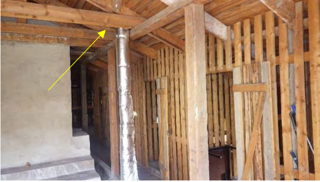
Kuvat 36 a ja b. a) Yleiskuva asuntosiiven ullakosta. Ullakon keskiosalla on vanhoja hormeja sekä rakenneaineisia ilmanvaihtokanavia. Ullakkotiloissa on erillisiä varastokoppeja. b) Yksittäisissä kattoläpivienneissä havaittiin vanhoja vuotojälkiä. Piikkikosteusmittarilla kohdat olivat kuivia.
