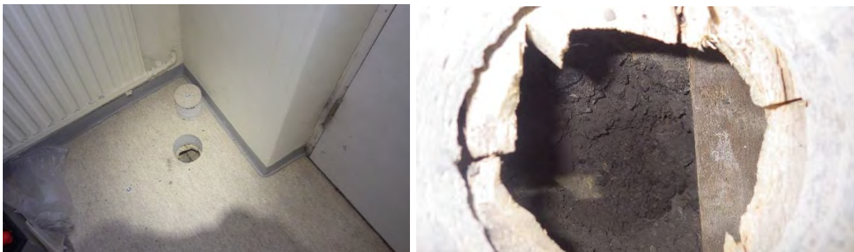
Kuvat 32 a ja b. a) Rakenneavaus RA-VP8 asuntosiiven 3. kerroksen välipohjaan. b) Täytönä koksikuonaa ja muottilaudat paikoillaan.
