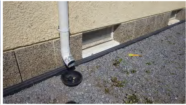
Kuvat 5a ja b. a) Lastentalon etelän puoleiselle sivustalle on asennettu jälkikäteen perusmuurilevy sekä sadevesiviemärointi lastentalon kellarikerroksessa havaittujen kosteusongelmien johdosta. Kellarikerroksen ikkunat ovat hyvin lähellä maanpintaa. b) Lähikuva perusmuurilevystä.
