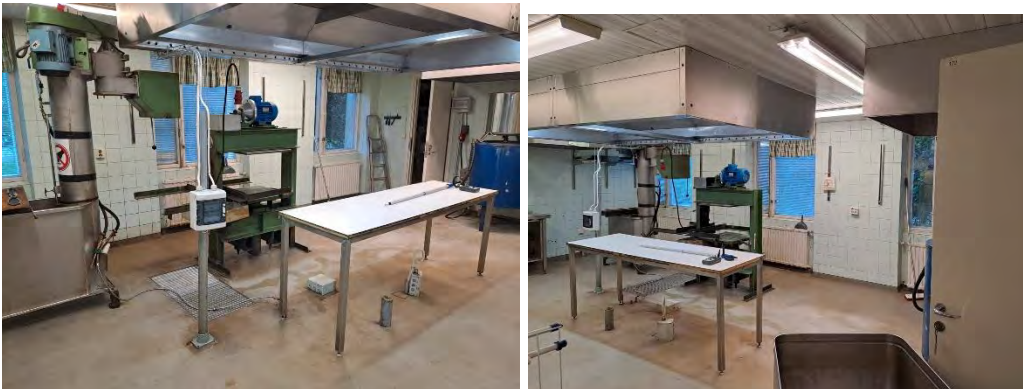
Kuvat 59 a ja b. Yleiskuva päiväkodin käytössä olleesta keittiöstä (tila 124). Lattiassa tai seinissä ei todettu poikkeavia pintakosteusilmaisimen lukemia.
