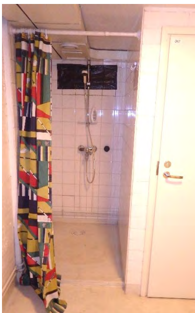
Kuva 55 a ja b. Yleiskuva tilasta 011. Seinälaattoja irti tai irtoamassa seinästä.
