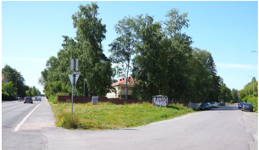
Kuva 11: Suunnittelualueen itäosassa tontilla 578-2 sijaitseva muuntamorakennus idästä kuvattuna. Puiden lomasta pilkottaa lastentalon päiväkotipääty. Tampereen kaupunki 2022
