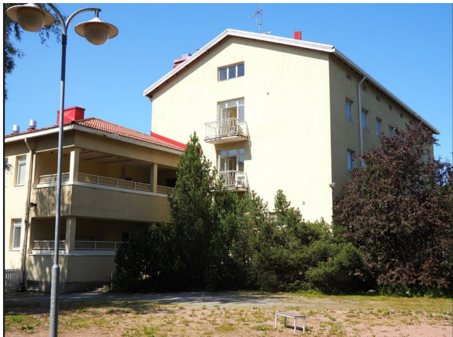
Kuva 5: Päiväkodin ja asuinsiiven yhtymäkohta etelästä kuvattuna. Tampereen kaupunki 2022
