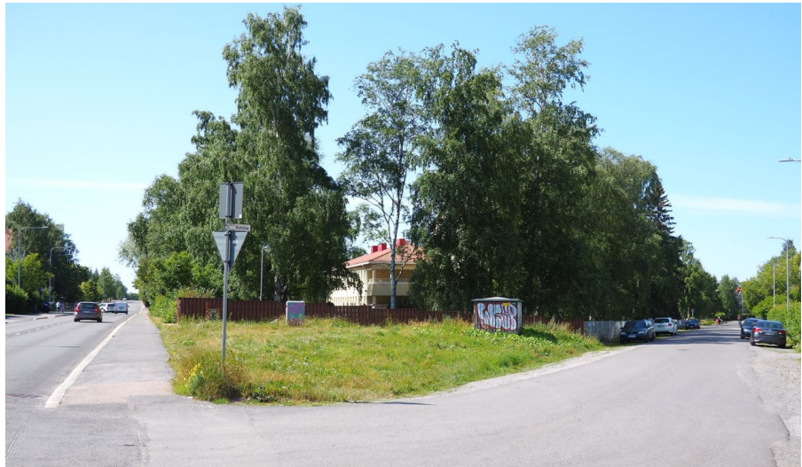
Kuva 11: Suunnittelualueen itäosassa tontilla 578-2 sijaitseva muuntamorakennus idästä kuvattuna. Puiden lomasta pilkottaa lastentalon päiväkotipääty. Tampereen kaupunki 2022
