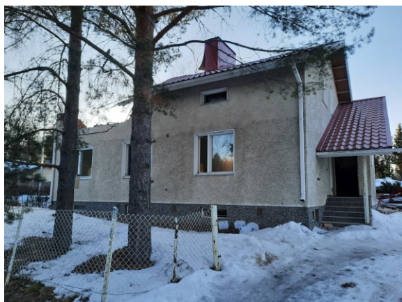
Kuvat 1 ja 2. Näkymä Routamaankadulta tontille. Vanhaa rakennusta puretaan parhaillaan. Anna-Kaisa Anttila 2021.
