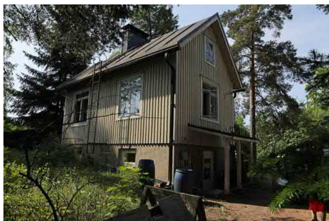
Tontin numero 1 rakennuksen etupuolella on suuri mänty.
