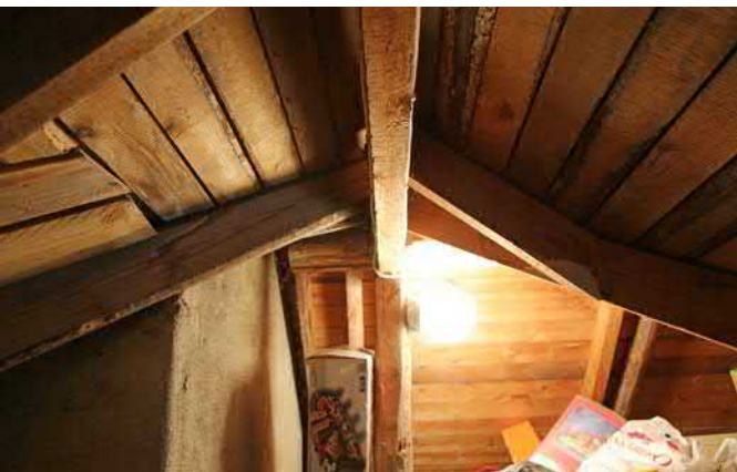
Ullakkoa ja katon rakenteita.
