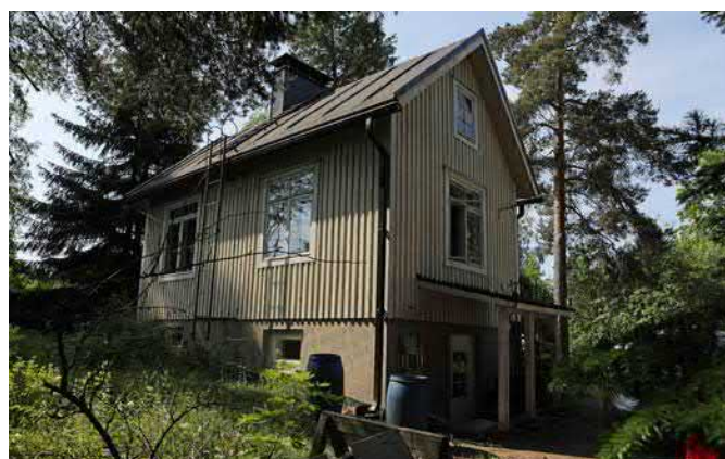
Julkisivu päädyistä (pohjoisesta).
