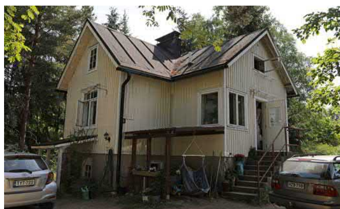
Julkisivu edestä (lännestä).
