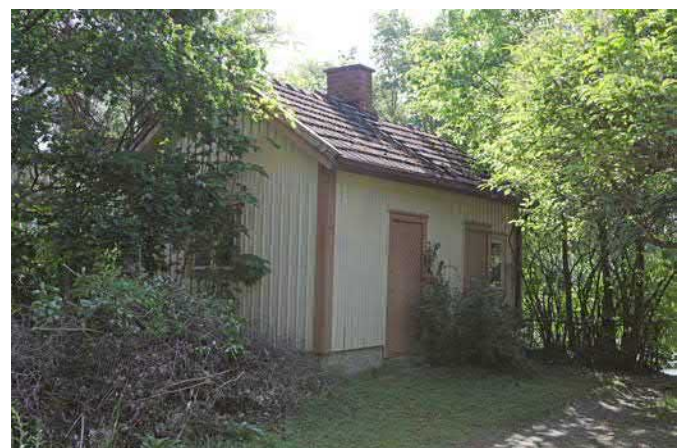
Säilytettäväksi ehdotettu entinen saunarakennus nykyinen varasto.
