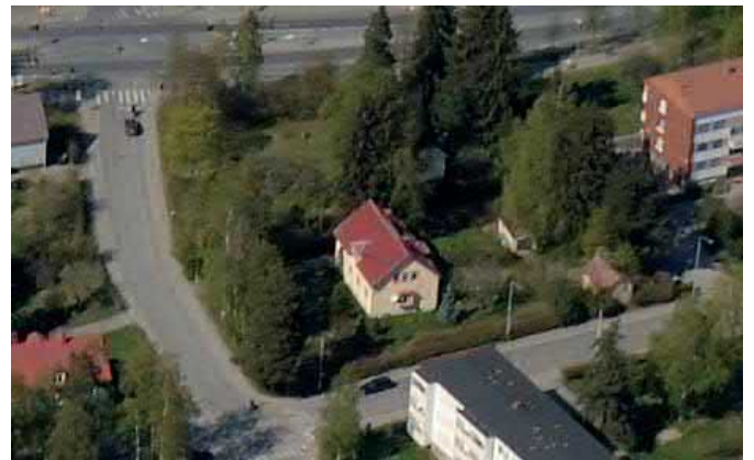
Pientalokortteli 738 on esimerkki Rantaperkiön vanhimmasta rakennuskannasta 1920-1930-luvuilta. Tämä selvitys syvennyy kyseiseen kortteliin tarkemmin seuraavassa osiossa.
