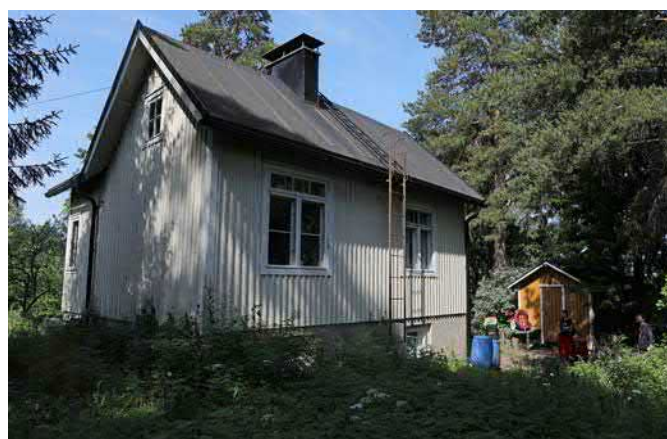
Julkisivu takaa (idästä).
