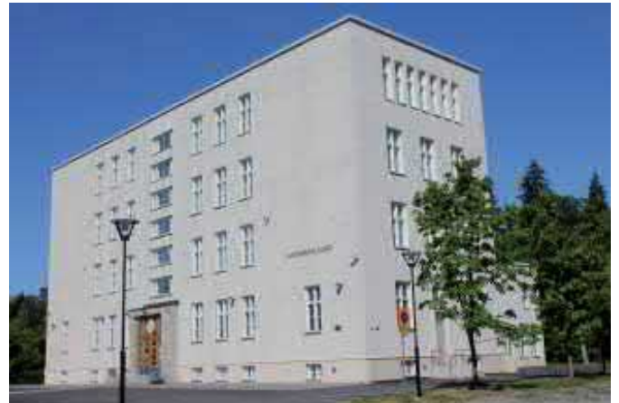
Entinen Rantaperkiön koulu, nykyinen Hatanpään lukio edustaa alueen vanhinta ajallista kerrostumaa. Koulu valmistui 1925 ja sen suunnitteli Bertel Strömmer. Kahden kerroksen korotus tehtiin vuonna 1937.
