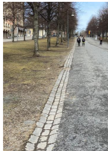
Kuva Hämeenpuiston keskikäytävän kivetystä hulevesikouru (FCG, 2023)
