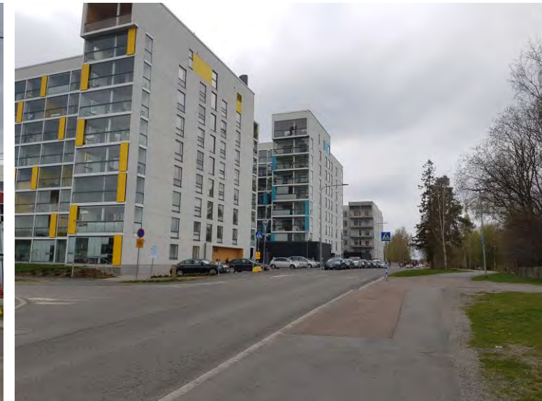
Teivaalantien ja antti possin kujan liittymä 10.5.2020
