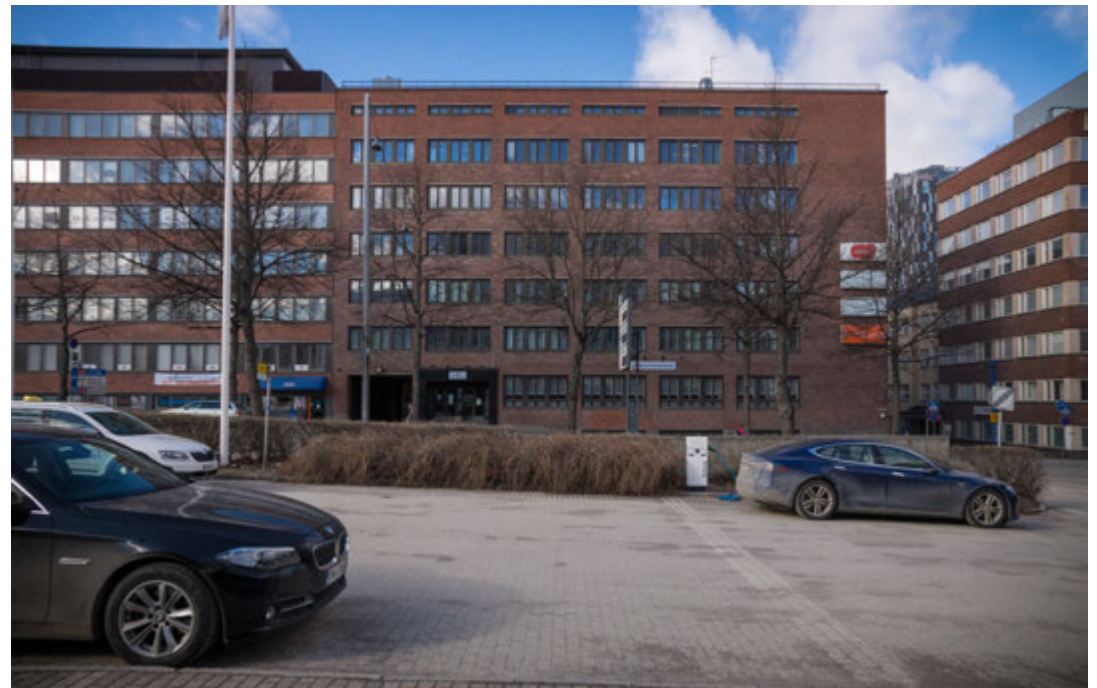
54. Julkisivu Yliopistonkadulle ja Tampere-talon suuntaan. Porttikäytävän oikealla puolella vuonna 1997 suunniteltu ravintolan sisäänkäynti kehysaiheineen. Oikeassa reunassa Lääketehdas Star.
