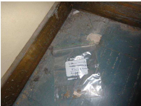
Kuva 4. Asbestipitoinen vinyylilaatta (250 x 250 mm 2 ), taukotila (suutari, ent. miesten pukuhuone) 102, yläkellari / 1. kerros, näyte 16.
