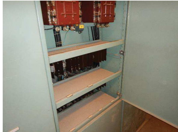
Kuva 7. Asbestipitoinen kuitusementtilevy, sähköjakamo 013 yläkellari / 1. kerros.
