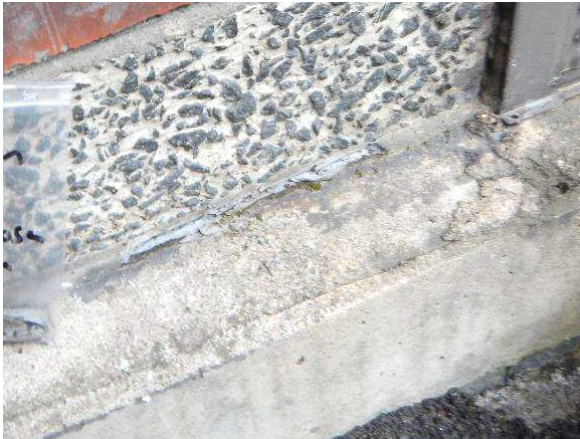
Kuva 18. Lyijyä yli vaarallisen jätteen raja-arvon sisältävä sokkelin saumamassa, näyte 49.
