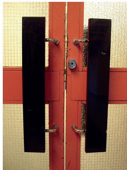
Ryhmätila, porrashuoneessa on alkuperäiset materiaalit ja kaitteet sekä ovet vetimiseen.
