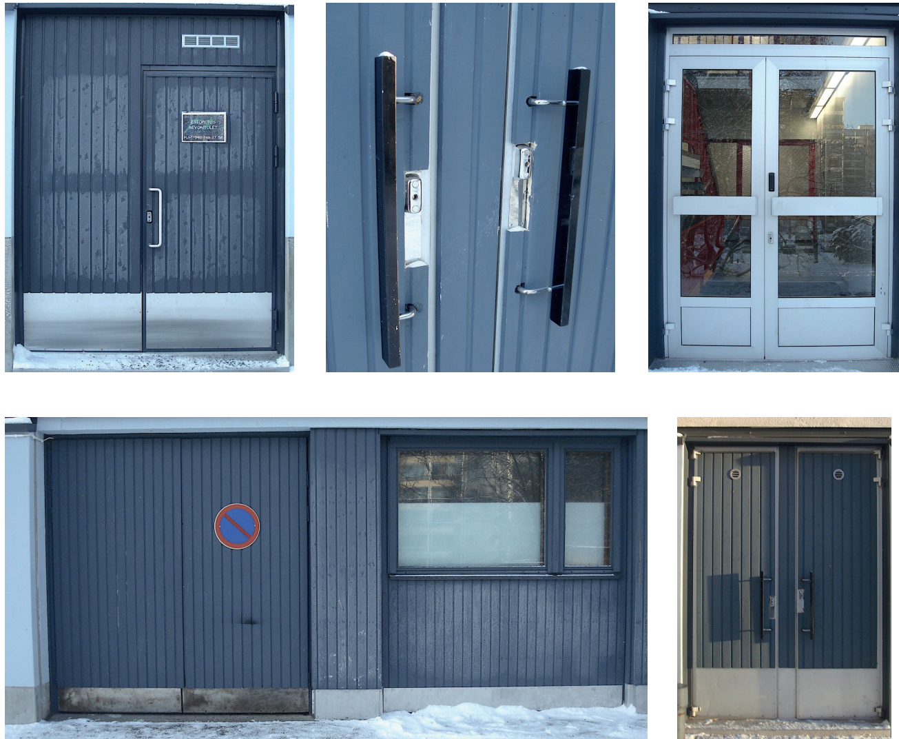
Vanhan mallin mukaan uusittu paneliovi, alkuperäisiä vetimiä, moderni alumiinilasiovi, vanha huolto-ovi ja alumiinirungolle rakennettu paneliovijäljitelmä.
