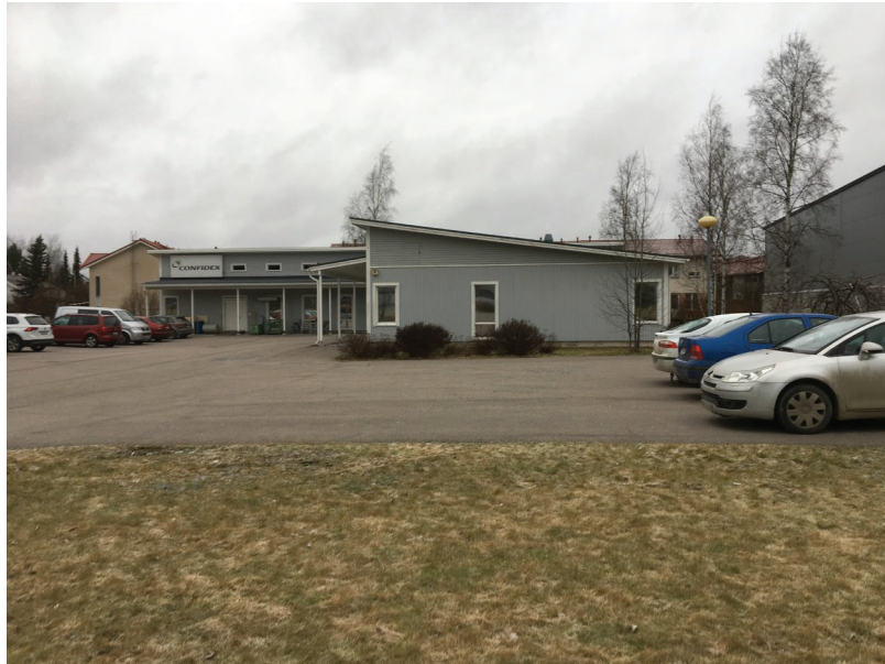
Toimistorakennus laajenee pysäköintialueelle. © Tampereen kaupunki 2020.
