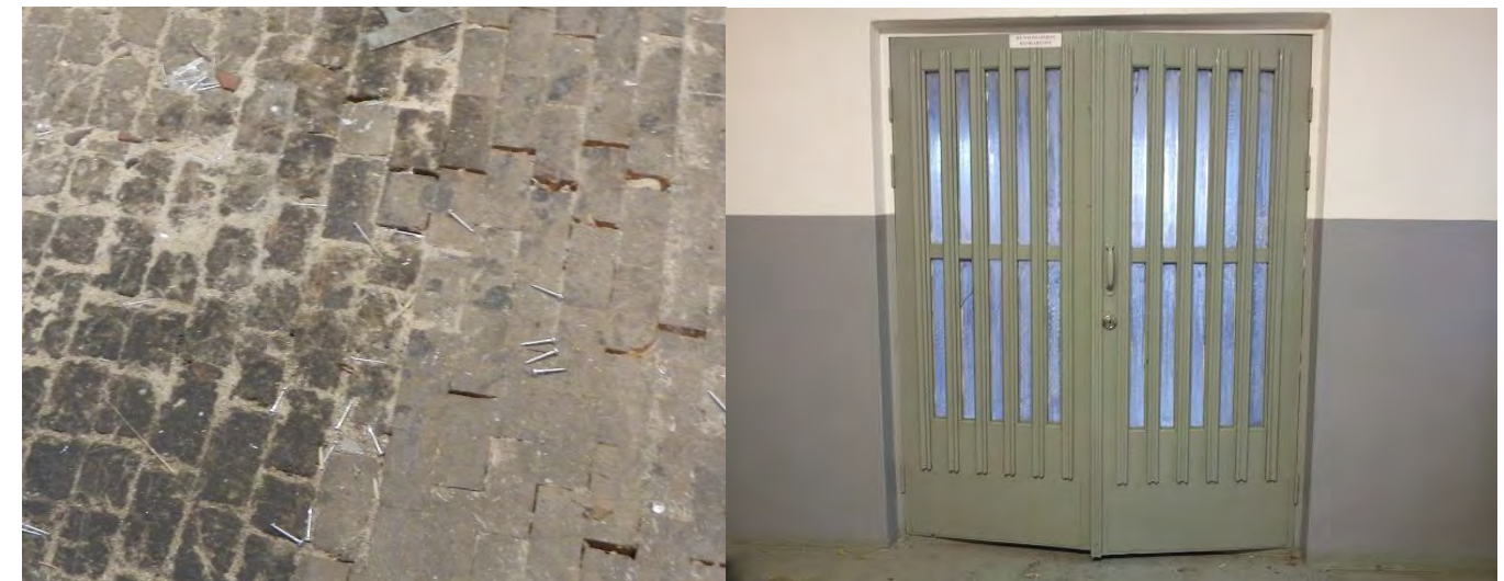
Oikealla ylhäällä rakennuksessa toimiva puyutyöverstaas. Alakuvissa vasemmalla vanhan osan alkuperäinen lankunpätkestä ladottu pajan lattia. Oikealla uudemman osan yläkerrassa sijaitsevan ruokalan alkuperäinen ovi.
