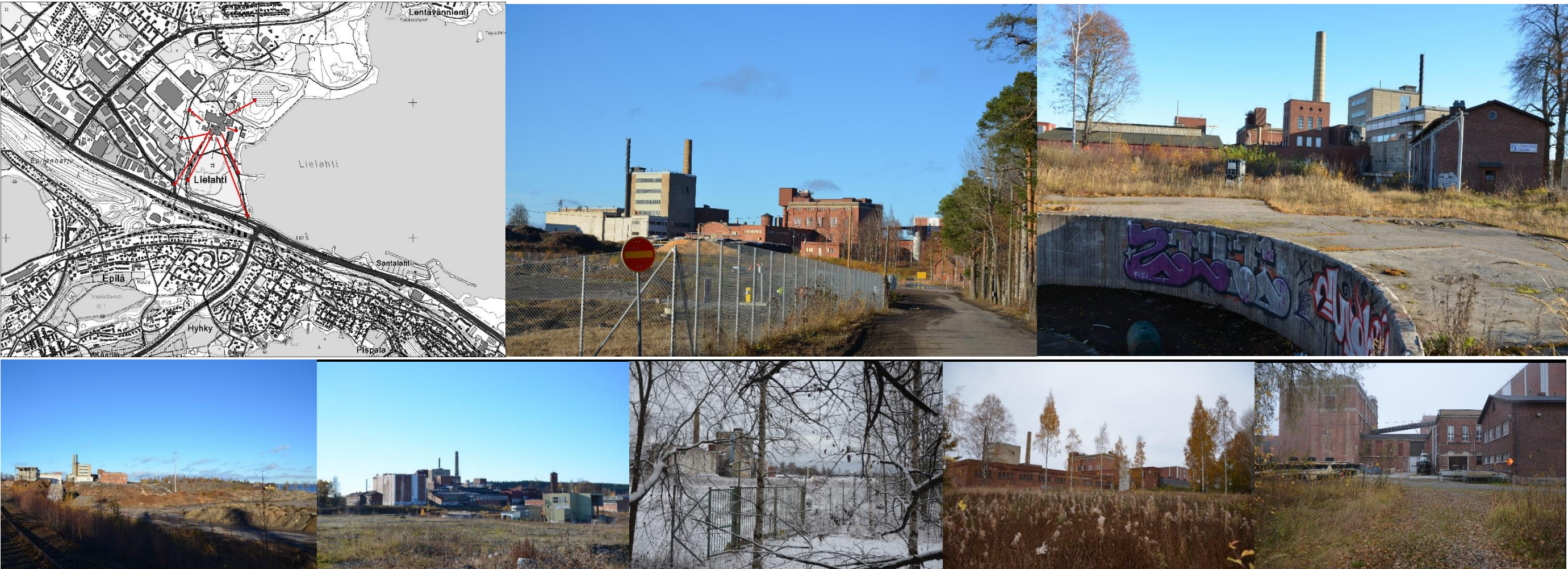
Kartta: Tehtaan julkisivuja ja keskeisiä näkymäsuuntia. Kuvat yläriivi: tehdas eteläpuolelta, entisen Teivaalantien suunnasta sekä länsipuolelta, kylätontin takaa. Alarivin kuvat vasemmalta: tehdas eteläpuolelta, teollisuusradan penkereeltä. Koillisesta, Ollinojanlahden puhdistus- ja maanläjitysalueelta. Talvikuva länsipuolelta, kappelilta. Kaakkoispuolelta, kartanon puistokujanteelta sekä itäpuolelta kartanolta.
