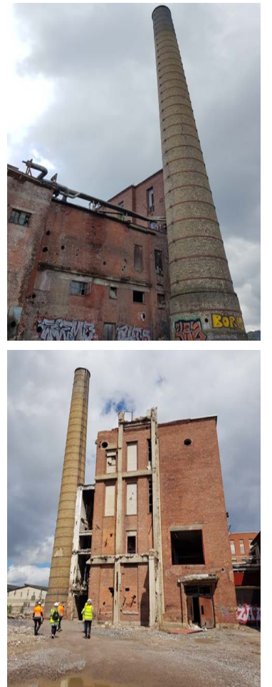
Voimalaitoksen tiilipiippu on alunperin vuodelta 1914.
