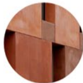
Värjätyt betonipinnat ( poislukien maalatut)
