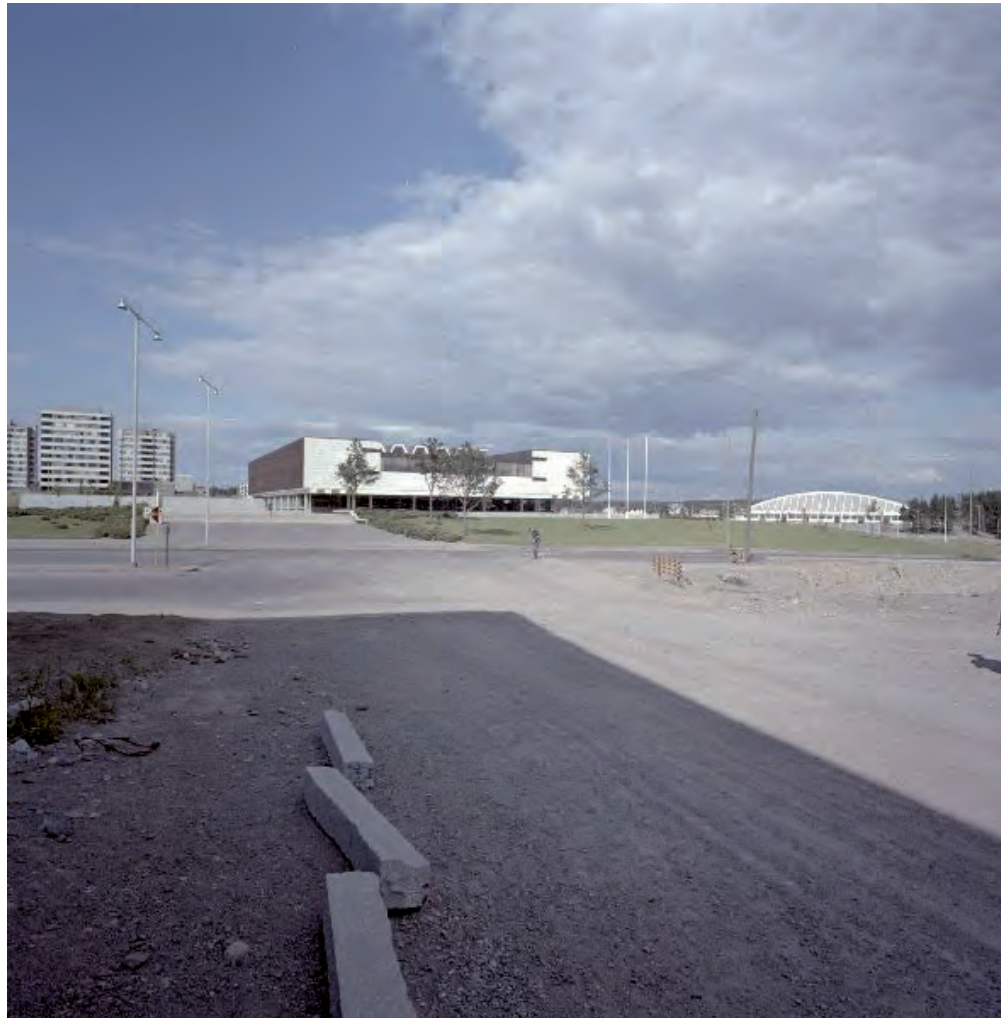
Etualalla arkkitehtien Timo Penttilän ja Kari Virran suunnittelema Tampereen kauppaoppilaitos ja taustalla Jaakko Tähtisen suunnittelema Hakametsän jäähalli. Molemmat rakennukset valmistuivat vuonna 1965 ja niiden molempien arkkitehtuuri edustaa Tampereen 1960-luvun rakentamisen korkeinta tasoa. Kuva Vapriikin kuva-arkisto.
