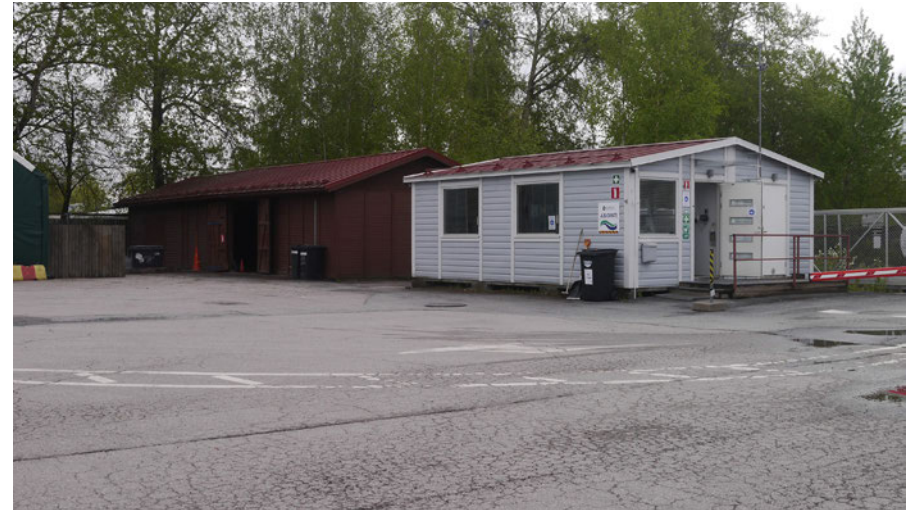
Jäteaseman toimisto sekä varistorakennus luoteesta
