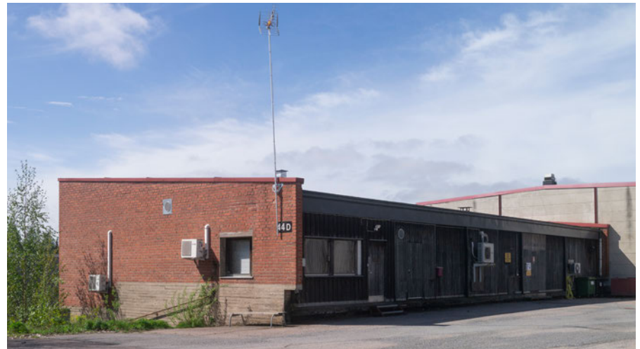
Alkuperäinen rakennusosa ja kulmaan vuonna 1984 lisätyt ikkunat
