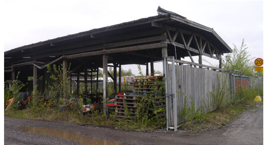
Kaakkoiskulman katos koillisesta
