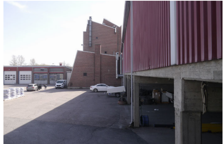
Konekorjaamo pohjoisesta. Oikealla vuonna 1991 rakennettu varastosiiپی
