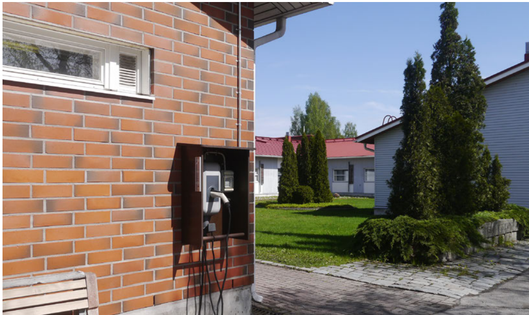
Uuden ja vanhan rakennusosan muodostama sisäpiha
