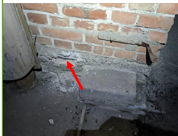
B-halli: tiiliväliseinän perustukset alkaneet rapautumaan, ruostunut teräs pinnalla
