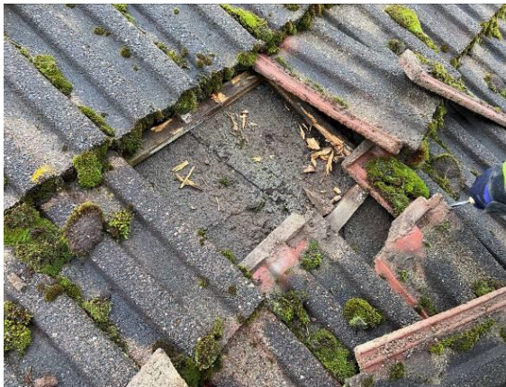
C-halli, länsi: tiilikate painunut, ruoteet lahonnut
