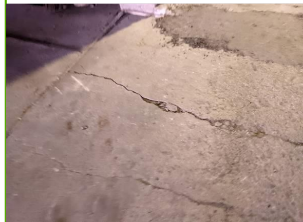
B-varasto: alapohja halkeillut ja lohkeillut, jälki-valu tehty korkoerojen vuoksi
