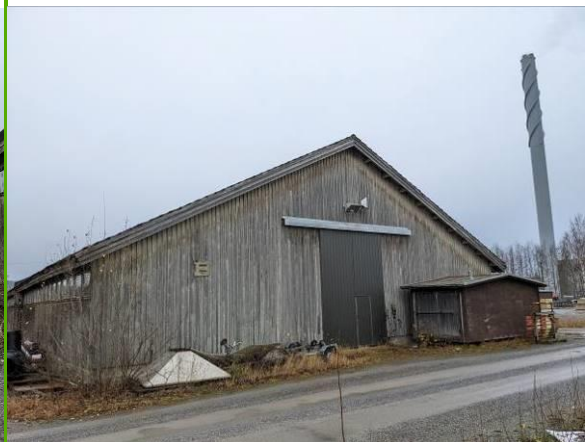
Yleiskuva pohjoispuolelta rakennuksesta ja alueesta
