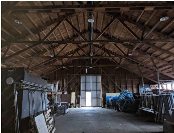
Yleiskuva C-varaston sisäpuolelta
