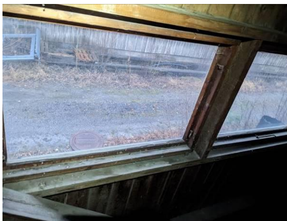
Yleiskuva ikkunasta sisäpuolelta
