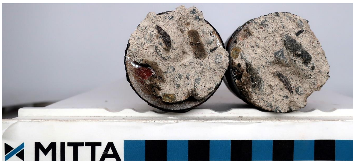
9, uusintaveto, sisäpinta vasemmalla.
