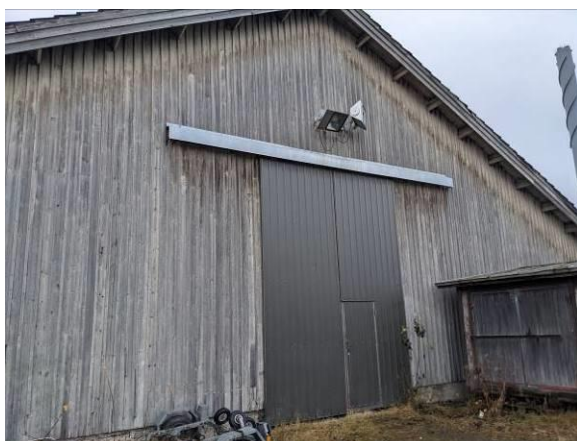
B-varaston pohjoispäädyssä uudempi ovi
