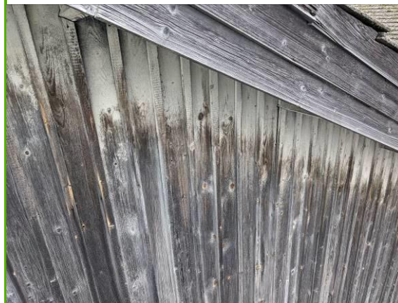
Maalipinnoite säilynyt ehjempänä räystäiden alta
