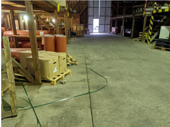
B-varasto: betoni kiviaineksella kulkuväylällä
