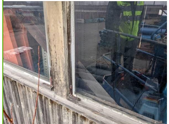
C-varasto: lasituskittauksia tippunut, kulmaraudat ruostuneet, maalipinnoite ehjänä välilistassa ylöspäin mentäessä
