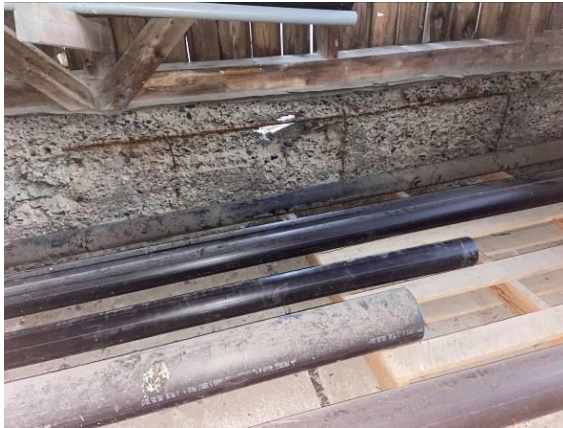
B-varasto, etelä: sokkeli rapautunut läpi, ruos- tuneita teräksiä sisäpinnalla
