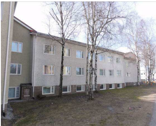
Maanpintojen muotoilut rakennusten pohjoispuolella viettävät osittain rakennukseen päin.
