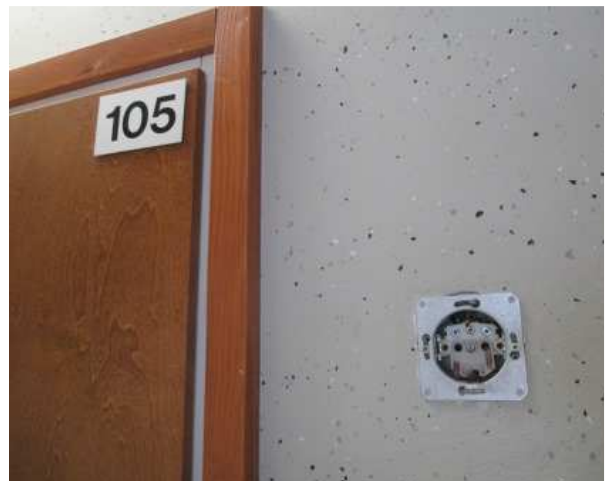
Pistorasiasta puuttuu kansi.
