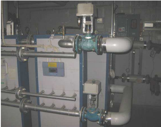
Lämmönsiirripaketin säätöautomaatiikkaa
