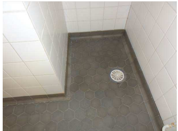
Yleisten tilöjen pesuhuonetta.
