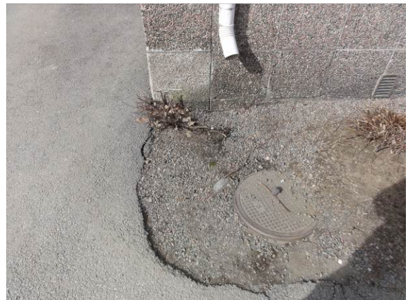
Pintavedet imeytyvät paikoittain rakennusten vierustoille.
