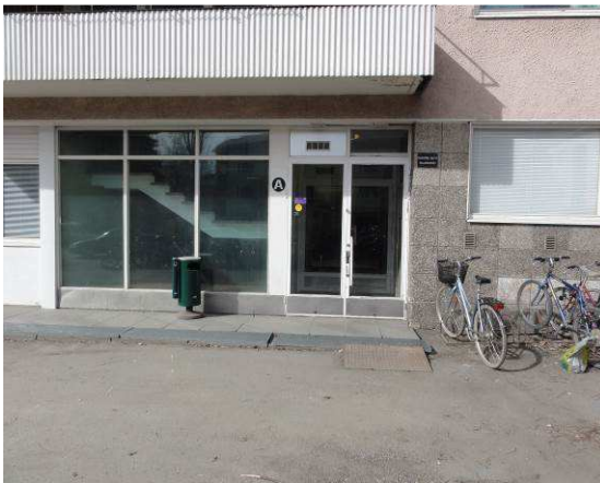
Teräsrakenteinen porrashuoneen ulko-ovi.
