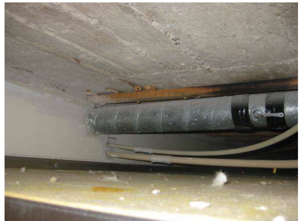
IV-kanavointia käytävän alas lasketun katon suojassa
