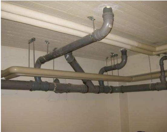
Muoviviemäröintiä A-talon kellarissa
