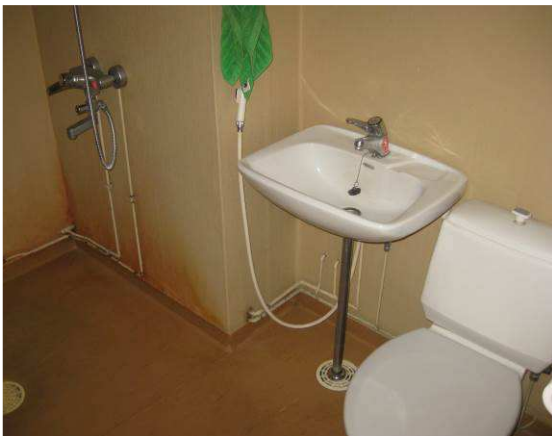
Asuntojen vesi- ja viemärikalusteet ovat pääosin peruskorjauksen ajalta
