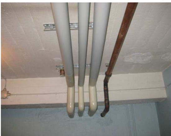
Vesijohdot on ilmeisesti uusittu pääosin kiinteistön peruskorjauksessa 1984
