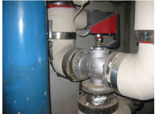
Lämmitysryhmän säätöventtiili
