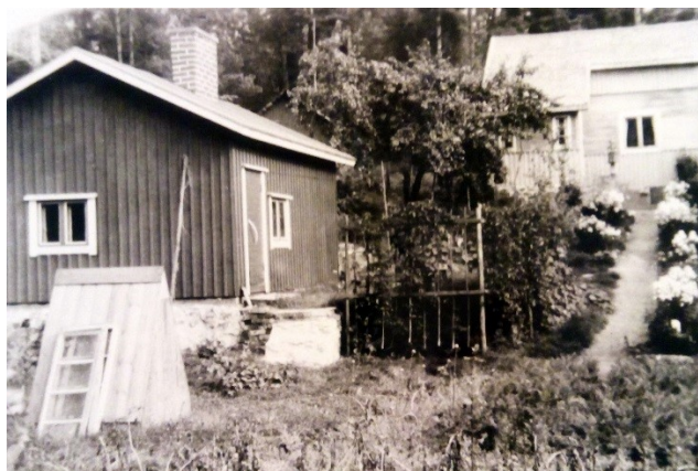
Kuva 5. Tontilla on sijainnut myös saunarakennus, jonka harja on ollut vastakkaiseen suuntaan kuin nykyisen saunarakennuksen.
