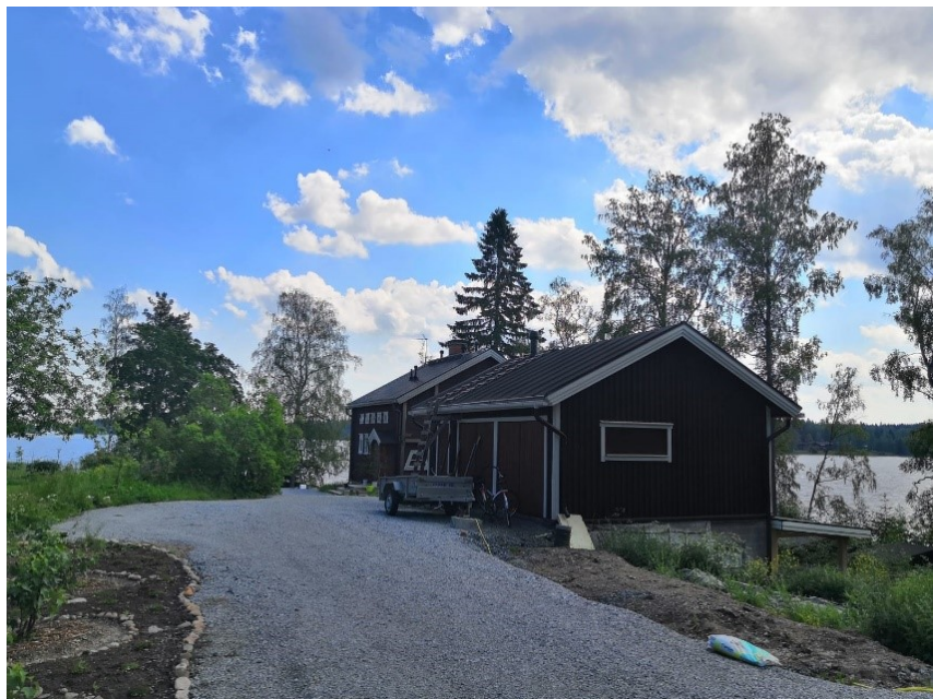
Kuva 4. Kuvassa etualalla autotalli ja sen takana asuinrakennus.
