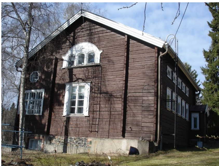
Kuva 1. Suunnittelualueen huvilarakennus yläpihalta katsottuna v. 2011. Oikeassa etukulmassa nähtävissä poistetun oven ja parvekkeen kohta. © Tampereen kaupunki 2011
