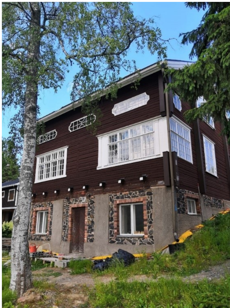
Kuva 6. Päärakennus takaa kuvattuna. Kuvat: © Tampereen kaupunki 2019
