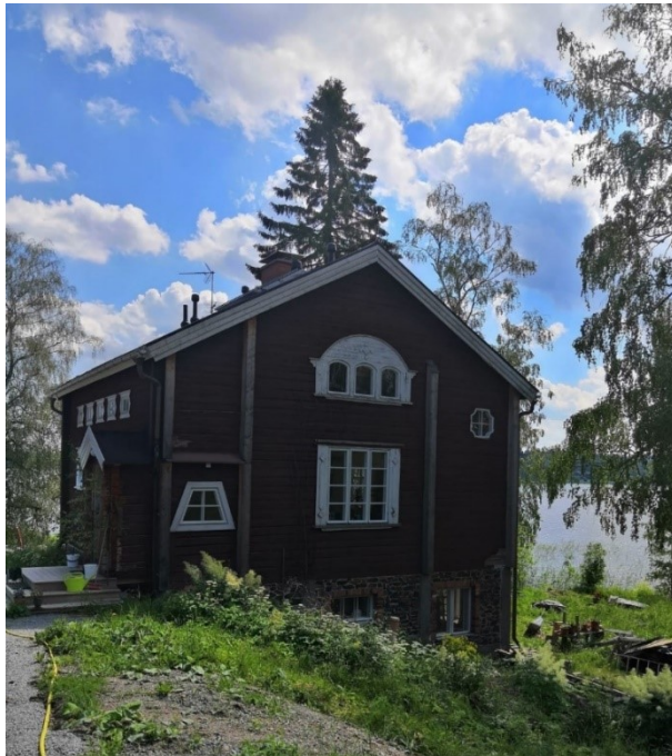
Kuva 8. Päärakennus idän puolelta kuvattuna.
