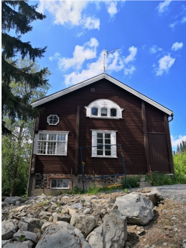
Kuva 7. Päärakennus lännestä päin kuvattuna.
