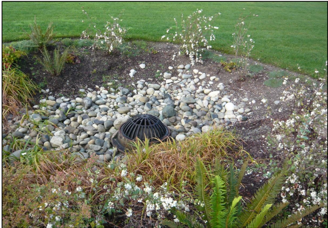
Kuva 5 Esimerkkikuva mahdollisesta suodatinkerroksen yläpuolisesta kasvillisuuden peittämästä painanteesta (Viherpainanne Seattlesa 6 ) Ylivuoto kupukaivon kautta.
