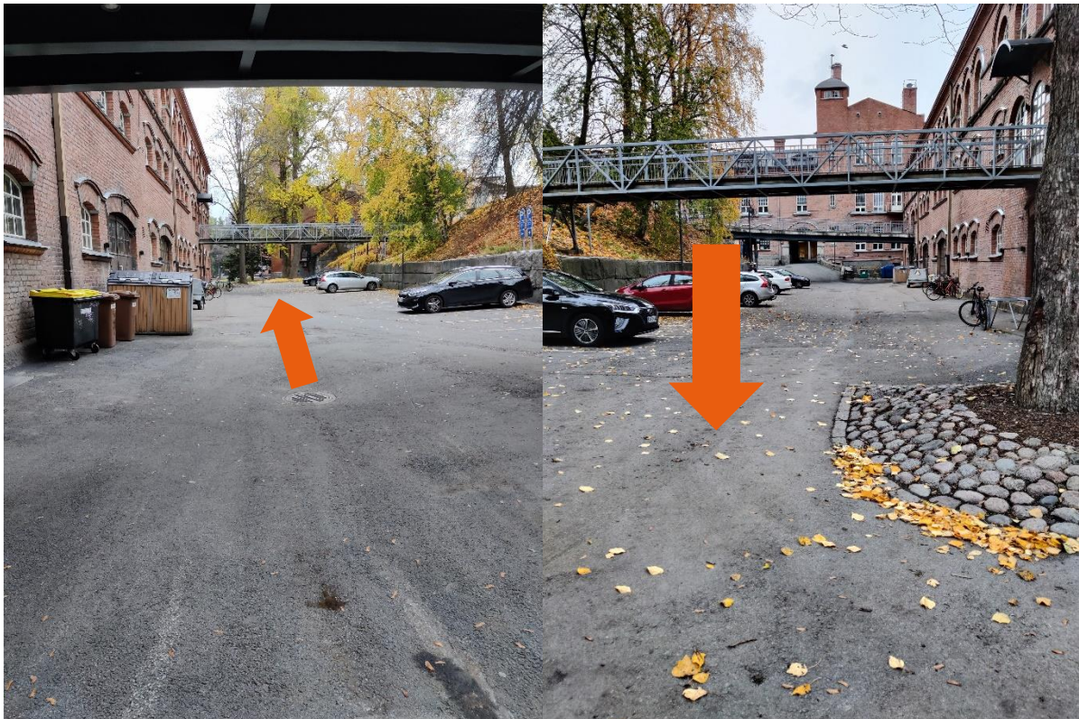
Kuva 10 Tasaus nousee nuolen osoittamassa paikassa ja heikentää maanpäällisen tulfareitin toimintaa
