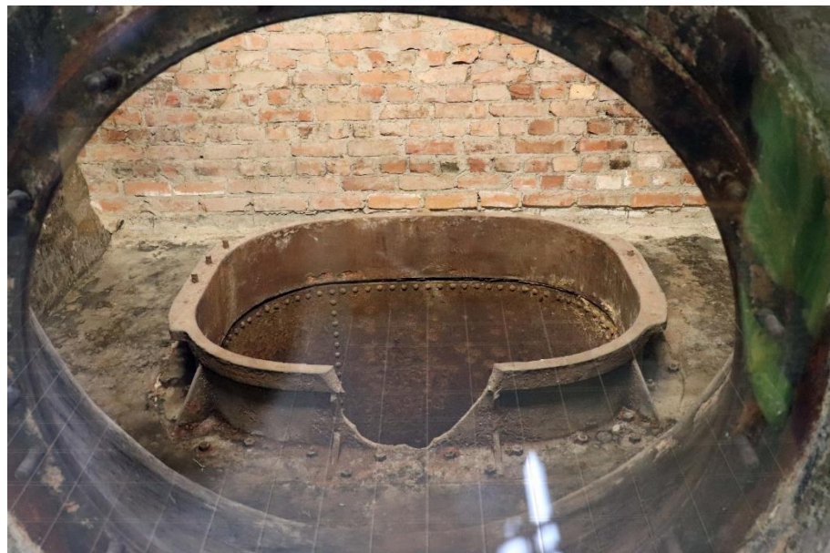
Kuva 9. Sähkölaitokseen kuuluneen laitteen osa nykyisen Frenckellin tehtaan koskisiiven eteläosassa saunaosastolla.
