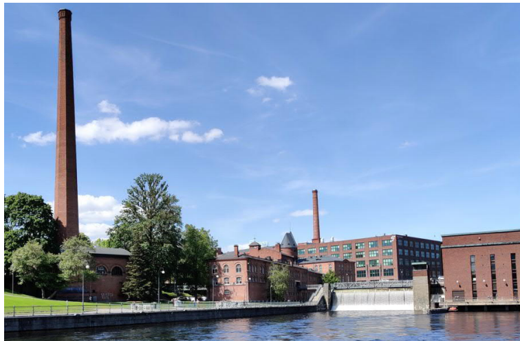
Kuva 9. Näkymä Tammerkosken yli kohti Frenckellin piippua, pannuhuonetta ja itse Frenckelliä. Frenckellin oikealla puolella näkyy Tammerkosken Keskiputous ja sen yhteydessä oleva voimalaitos. Putouksen takaa näkyy Finlaysonin entisiä tehdasrakennuksia. (FCG 2021)
