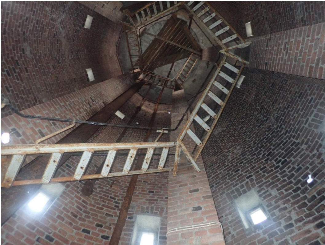
Kuva 4 Rakennuksen sisärungossa ei todettu vaurioita
