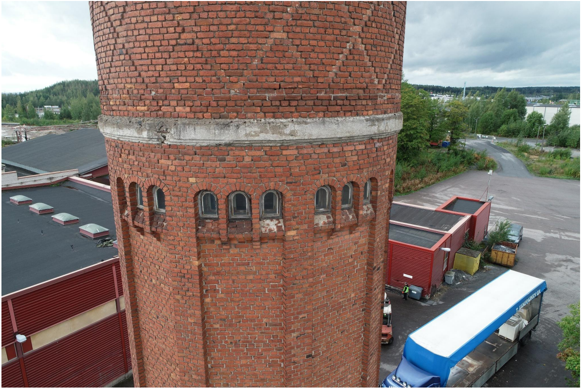
Kuva 6 Yleiskuvaa tornin keskiosasta.
