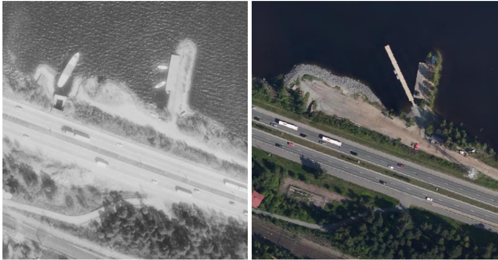
Kuva 13. Vasemmalla ote kantakaupungin ilmakuvasta vuodelta 1987 ja oikealla vuodelta 2018. Nippu-uittotunnelin suuaukon edusta patoaminen 2000-luvulla on katkaissut tunnelin suoran yhteyden Näsijärvelle vesistöön. Kuvallähde: https://kartat.tampere.fi/oskari/
