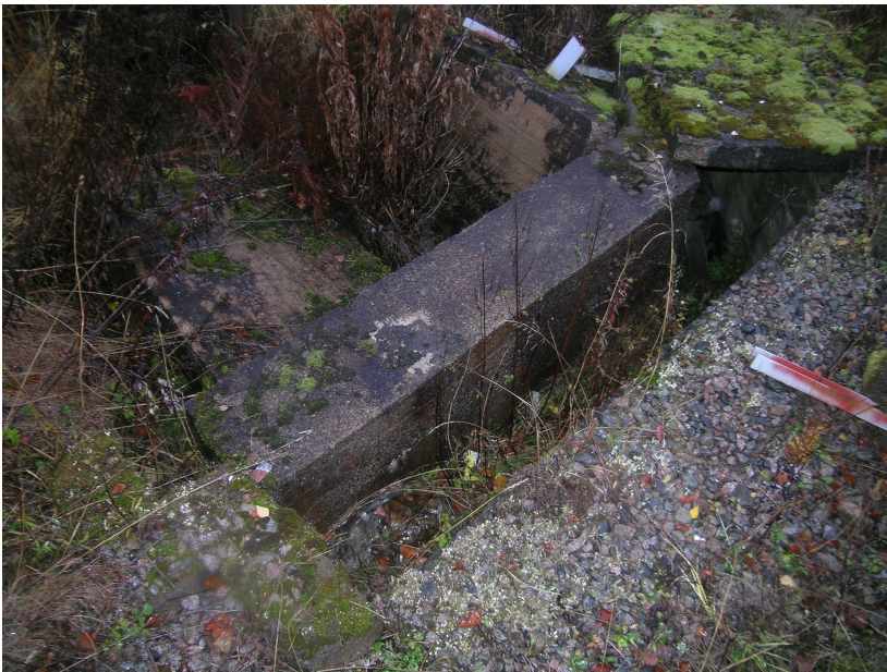
Kuva 3. Sepelikentän betonirakenteita. KYY 167: 16.
