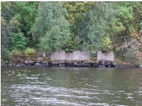
Laiturin 3 edessä oleva betoninen kivijalka rannassa.
