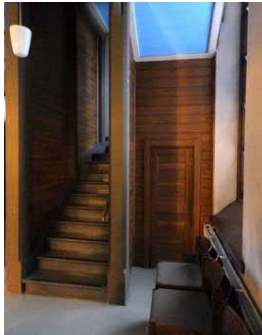
Vasemmalla: Portaiden alle siirretty WC.
