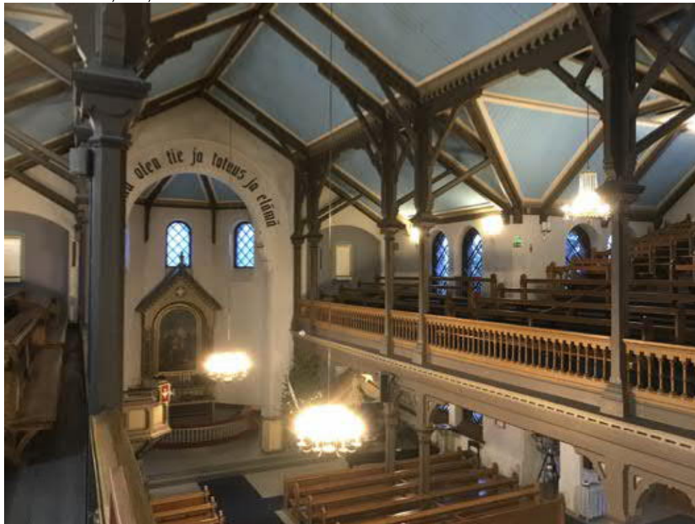
Kirkkosali. Kuvassaa erottuvat hyvin kirkon sisäkaton tukipilarit.
