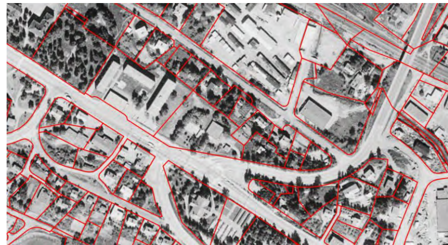
Kuva 37. Ote ilmakuvasta vuodelta 1974 ja nykyiset kiinteistörajat. Harjun pihapiireissä ja uuden kirkon ympäristössä puusto alkaa olla täysikasvuista ja entisille pelloille radan ympäristöön on rakennettu teollisuusaluetta. TOAS:n opiskelija-asunnot ovat valmistuneet. (Tampereen kaupunki, 2022)
