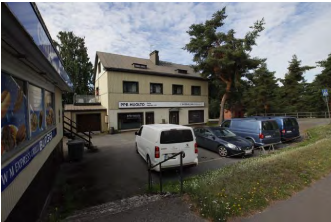
Kuva 34. Entisen kunnantalon länsipuolinen vuonna 1939 valmistunut asuinrakennus.
