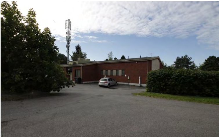
Kuva 76. Asfalttikenttää puhelinkeskuksen tontin edustalla. Kuvan vasemmassa reunassa näkyy tonttia reunustava pensasaidanne. Telemasto näkyy hyvin Messukylänkadulle.
