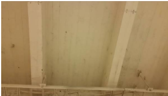
Yläpohjat ovat pääosin ylälaattapalkistoja
