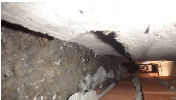
Räystäsrakennetta: villa paljaana, joka kolmas tiili on auki ylimmältä riviltä
