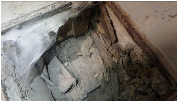
Rakennusjätettä ja muottilautoja luukussa
