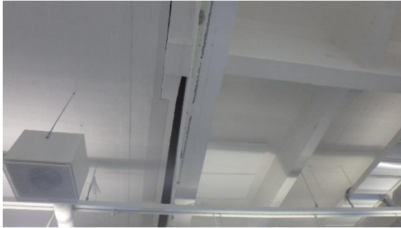
Välipohja vaihtuu kaksoislaattapalkistosta ylälaattapalkistikoksi
