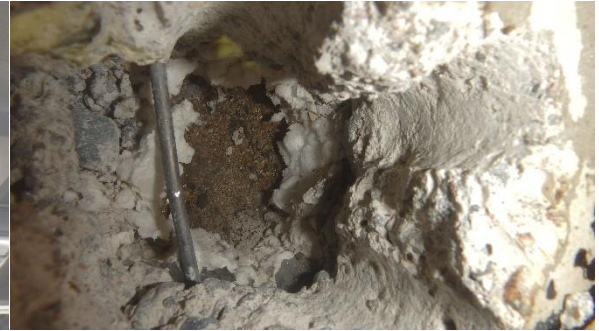
Kaksoislaattapalkiston ylälaatan päälle valettu uusia kerroksia, alla hiekkakerros, jonka alla vanha vesikate
