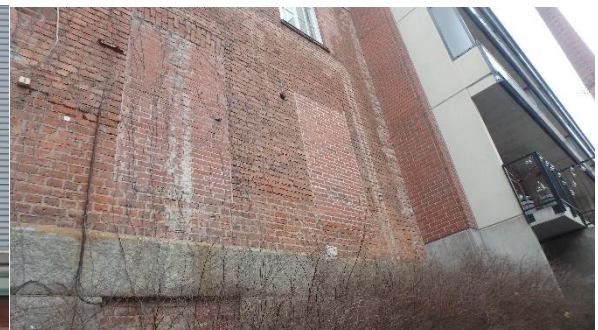
Aukkoja muurattu umpeen, rapautuneita tiiliä, sokkelissa kiverhous
