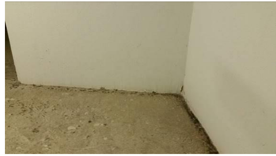
Epäpuhtauksia lattialla (VSS), tilasta lähtee ilmahormeja
