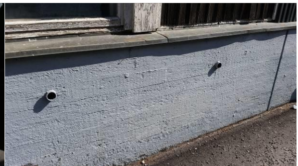
Tuuletusputkia sokkelissa, ikkunan puuosat ovat haristuneet ja niiden maalipinta on hilseillyt/kulunut
