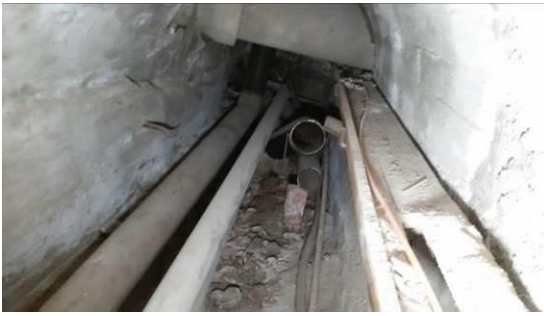
Kellarista lähtevä putkitunneli, rakennusjätettä tunnelissa
