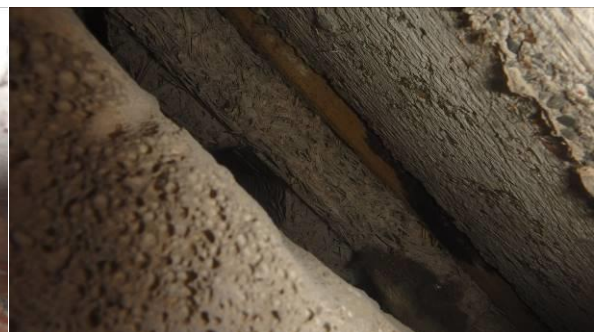
Räystäsrakennetta: betoniräystäessä aukko, josta näkyy Tojalevy ja lauta
