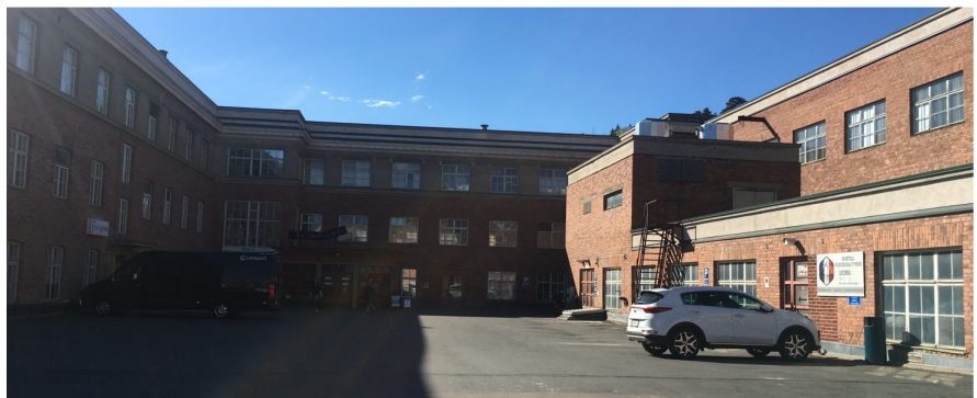
Kuvassa oikealla näkyvän kaksikerroksisen rakennusosan IV-konehuone on tarkoitus purkaa.
