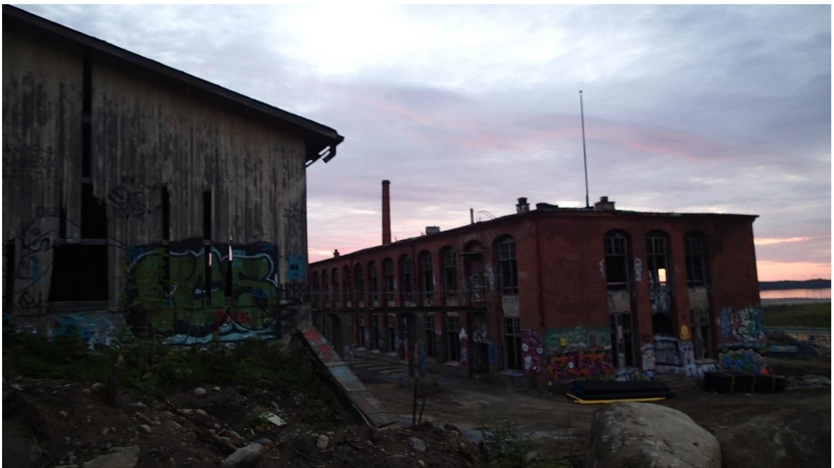
Kuva 6. Tikkutehtaan alueen rakennuksia
