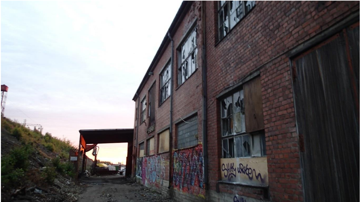
Kuva 10. Pahvitehtaan rakennuksen Pispalan puoleinen sivu
