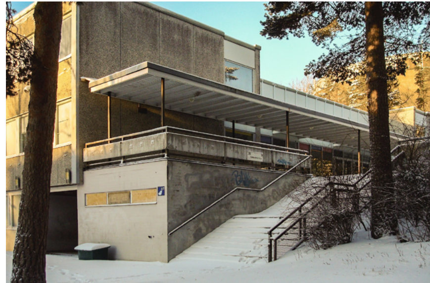
Kellarin teknisen tilan alkuperäisiä paneelioviovia, koulun eteläsivu, uusitut teräskaitteet ja alkuperäiset betonikaiteet.
