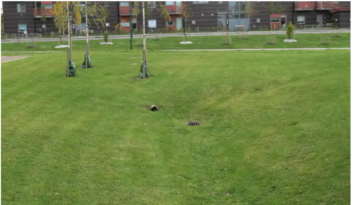
Kuva 4. Hulevesiä viivyttävä ja hidastava viherpainanne kupolisiiviläkannellisella ritiläkaivolla. (Kuva Leena Sänkiaho)
